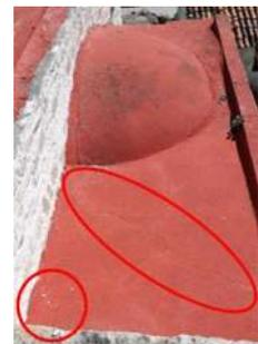
Fig. 107 Grietas en cubierta. Fuente: foto del autor
