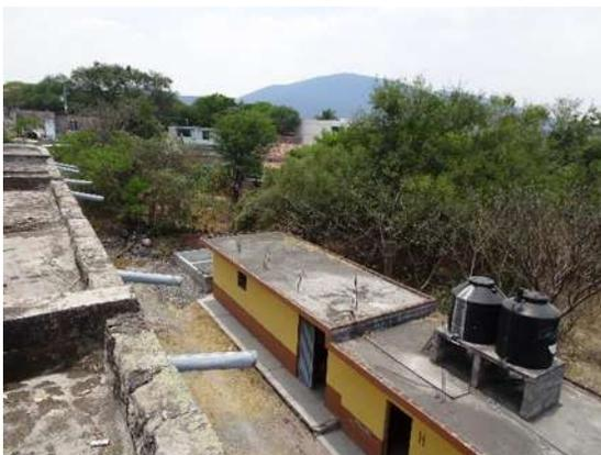
Fig. 102 Instalación hidráulica en baños e Instalación pluvial de tubos PVC en capilla San Juan. Fuente: foto del autor
