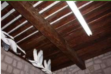
IM-48 Viga de concreto armado.
