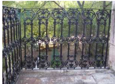
Barandal de herrería.
