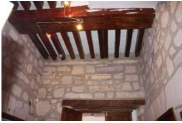
IM-49 Viga de concreto armado.
