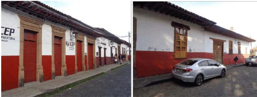
Fig.28. Fachada con cerramientos de vano de cantería labrada y vigas de madera respectivamente.
