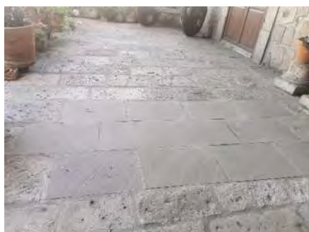
Figura 69: Piso de baldosa de cantera. Fuente: Laura Monforte
