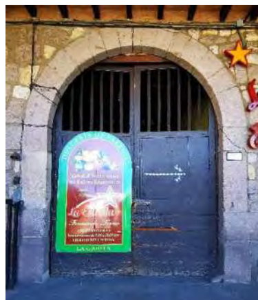
Figura 82: Arco dovelado Fuente: Laura Monforte
