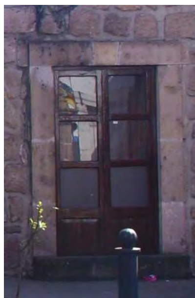
Figura 80: Platabanda dovelada Fuente: Laura Monforte
