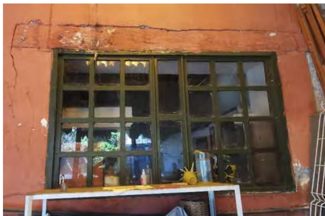
Figura 81: Cerramiento de madera Fuente: Laura Monforte
