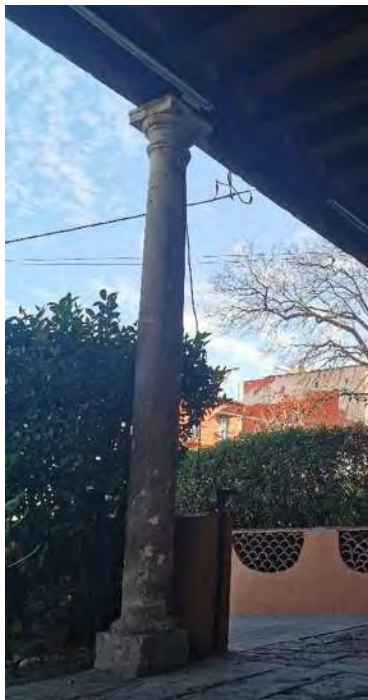
Figura 77: Columna de sillares de piedra
