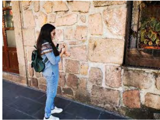
Figura 76: Muro de mampostería de piedra irregular, sin aplanado.
