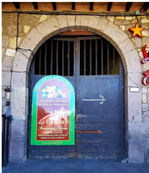
Figura 96: Puerta en arco de fachada principal Fuente: Laura Monforte
