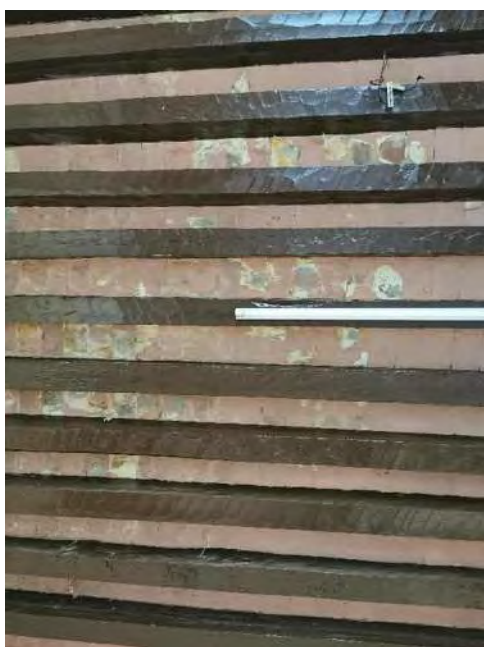
Figura 83: viguería en cubierta Fuente: Laura Monforte
