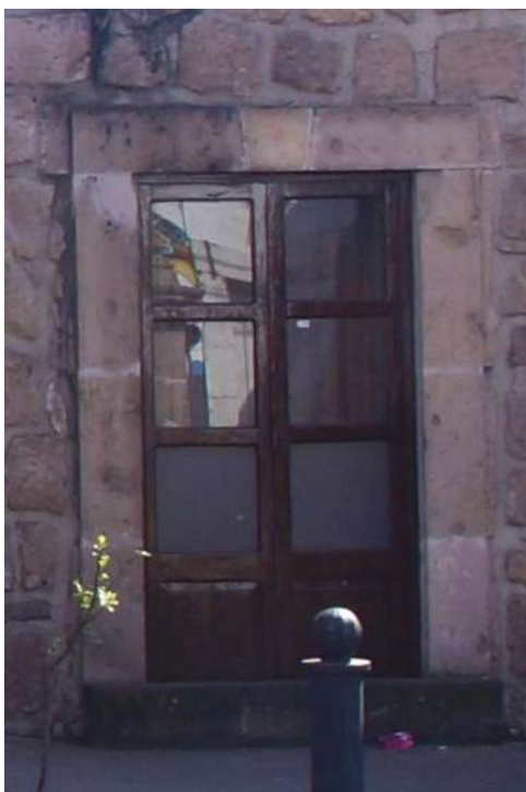
Figura 95: Ventana fachada principal Fuente: Laura Monforte
