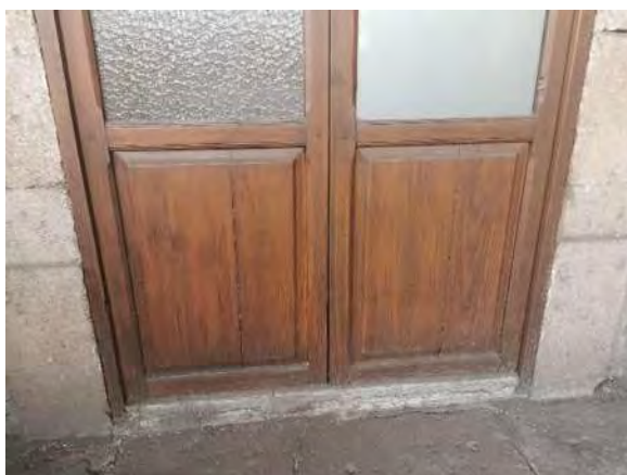
Figura 97: acercamiento a puerta Fuente: Laura Monforte
