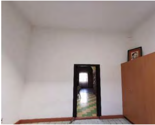
Figura 75: Muro de ladrillo con acabado cemento-arena.
