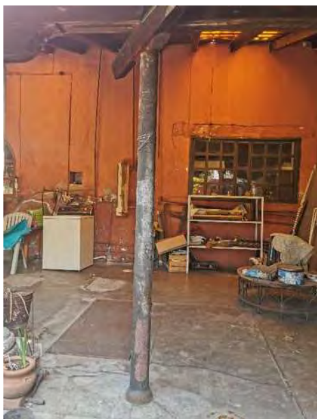
Figura 108: Columna de acero Fuente: Laura Monforte
