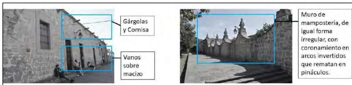
**Figura 44.** Diagrama elementos de la fachada 2.
