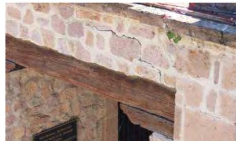
**Fig 106.** Grieta en el inmueble tesorería, **Fuente:** Autor
