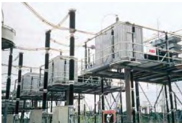
Figura 4. 3 CAS de la subestación emperatriz en Brasil.
