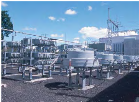
Figura 4. 2 CEV de la subestación de Lismore, en Australia.
