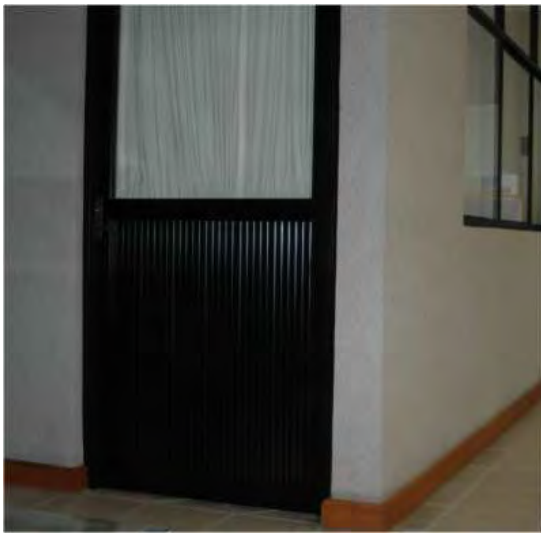
(a) La puerta y la pared forman dos líneas paralelas muy próximas
