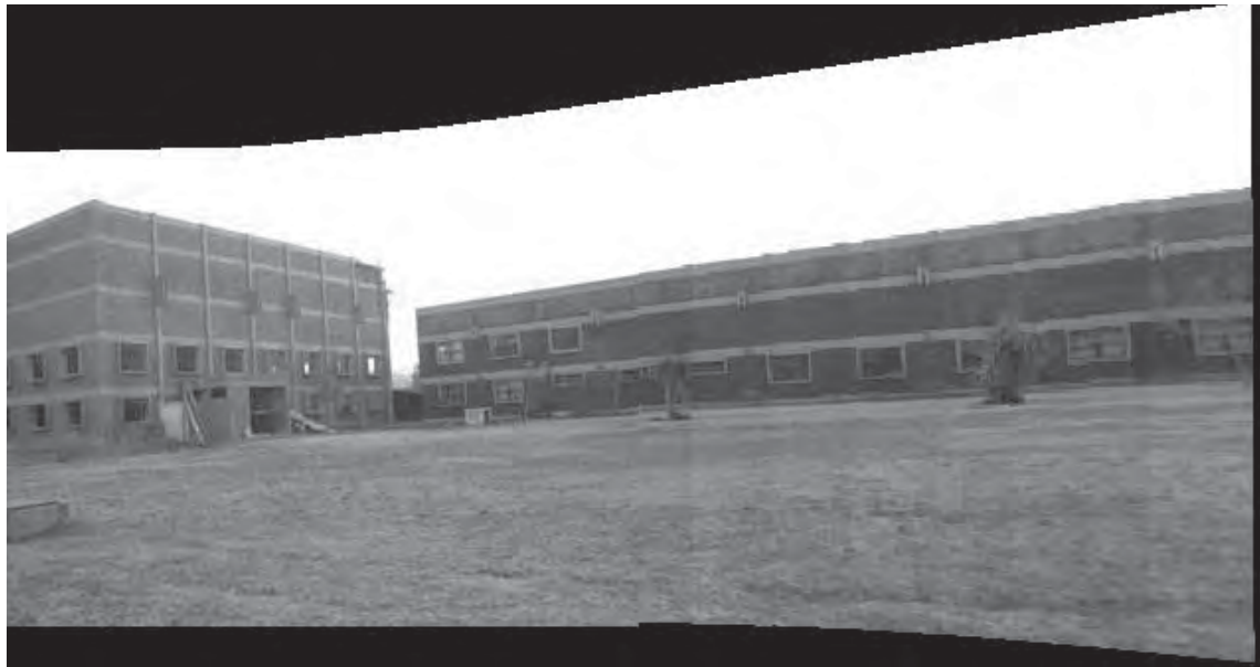
Figura 5.5: Imagen Panorámica del Edificio del Posgrado de la FIE estimado con GNLM-SSD-ARC
