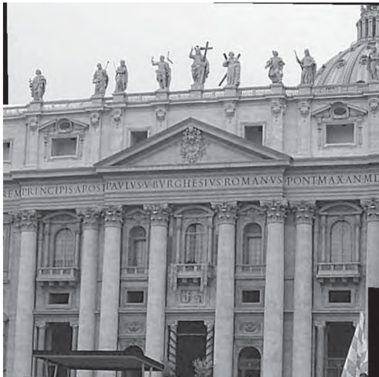
Figura 5.12: Imagen Panorámica de la Fachada del Vaticano
