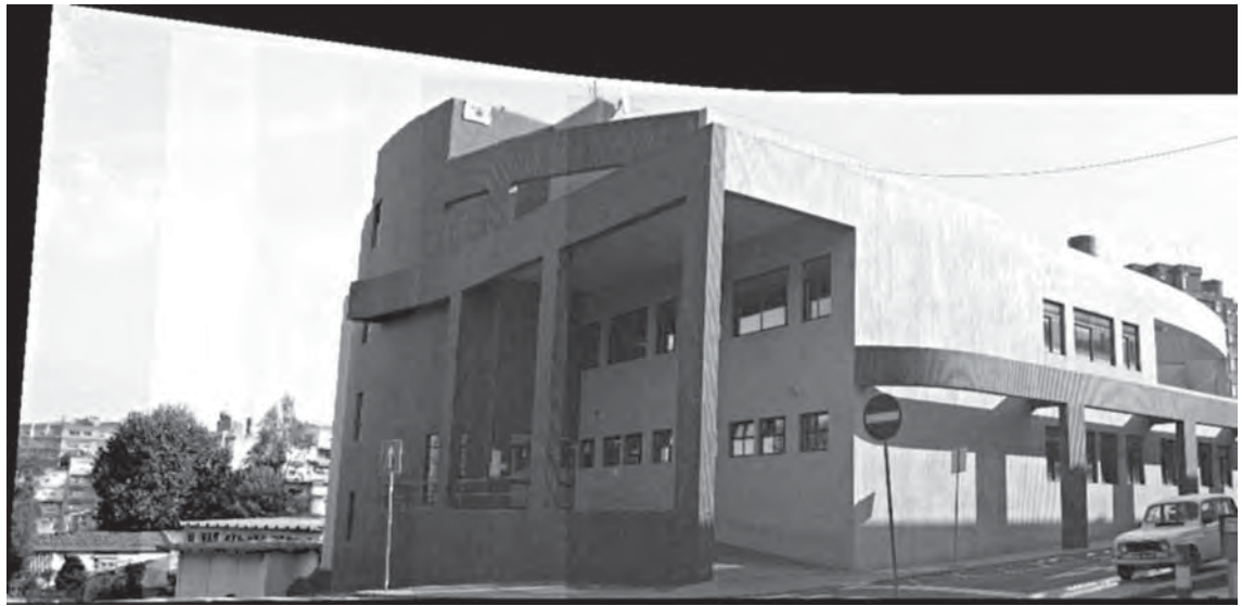
Figura 5.13: Imagen Panorámica de un Edificio Elaborada de Derecha a Izquierda
