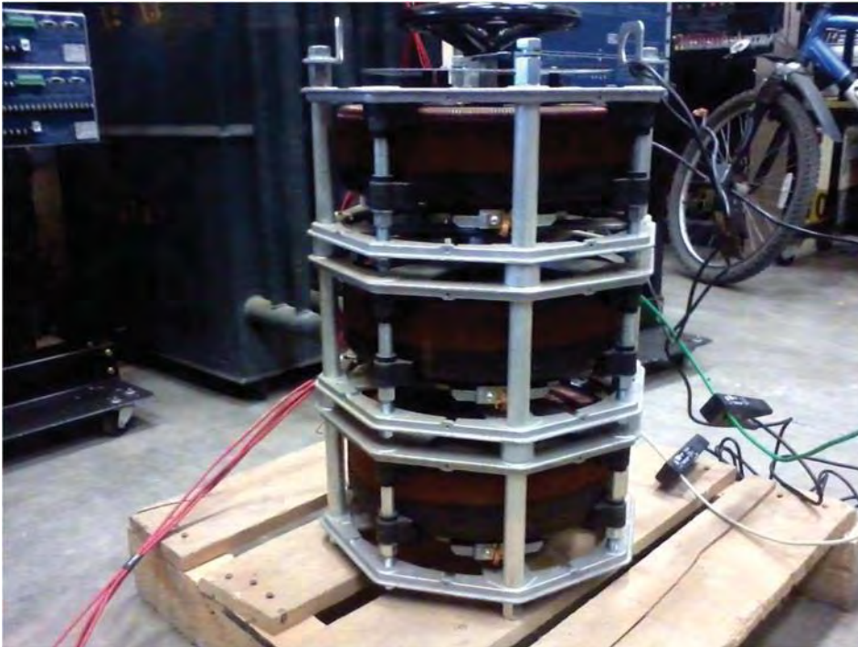
Figura 3.3 Autotransformador para alimentar el transformador de prueba.
