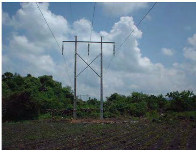
Fig 3.7 Estructura tipo H con postes de concreto
