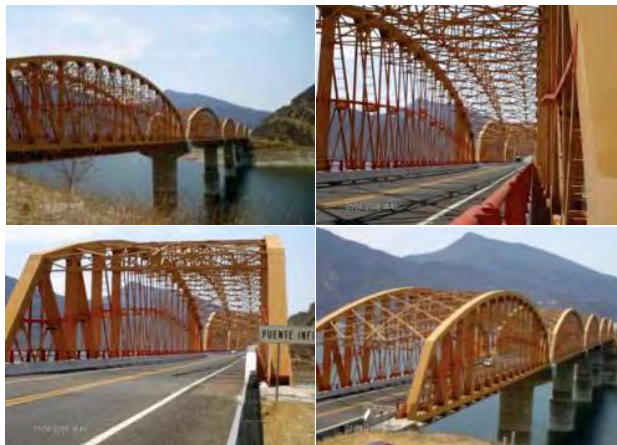
Figura 2-2: Puente Infiernillo II.
