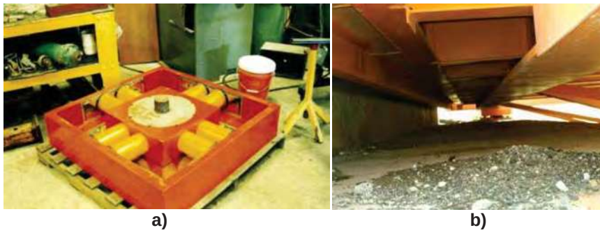
Figura 2-9: Aislador multirrotacional colocado en el puente, a) cortesía de Roberto Gómez, b) aislador en el estribo del puente.
