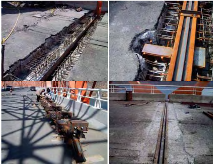
Figura 2-6: Juntas de dilatación del puente Infiernillo II (cortesía de Roberto Gómez).
