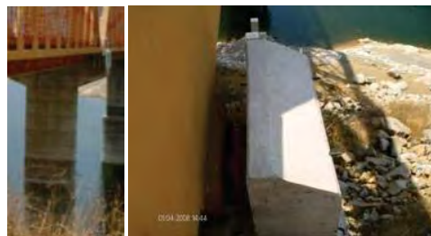
Figura 2-3: Topes sísmicos en cabezales y estribos.
