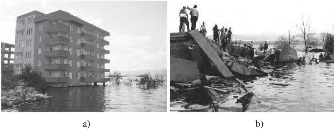
Figura 1.2. Fotografías de una construcción con un daño ligero provocado por el sismo de Kocaeli en Turquía, la cual tuvo un colapso total debido a una réplica de menor magnitud un mes más tarde: a) Después del evento principal ( $M_w=7.4$ ), y b) después de la réplica ( $M_w=5.9$ ) (Yeo, 2005).
