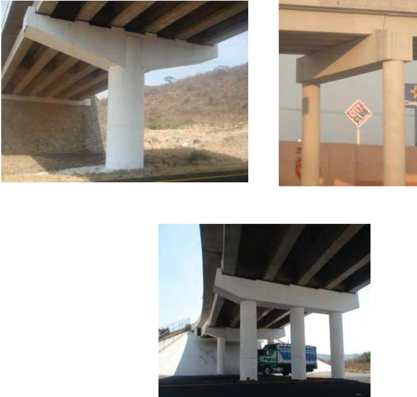
Figura 3.2. Configuración transversal típica de puentes de concreto reforzado construidos en el país.
