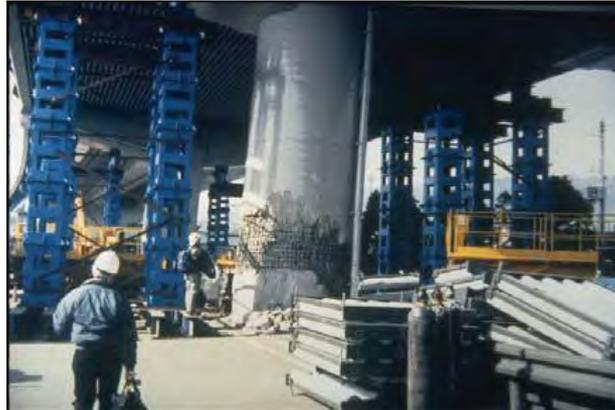
Figura 1.5. Pila del viaducto de Hanshin en la ciudad de Kobe con deformación lateral permanente después del sismo de Hyogo-Ken-Nambu de 1995.
