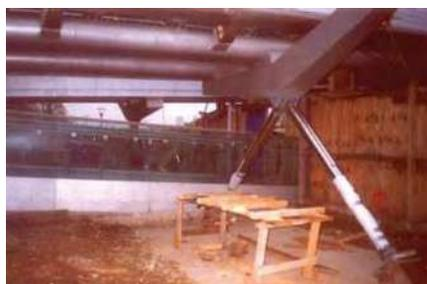
Figura 3 Amortiguadores colocados verticalmente Puente Milenio
