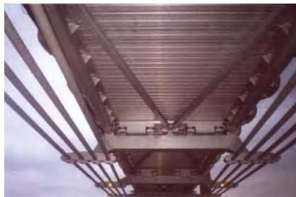
Figura 5 Amortiguadores tipo Chevron Puente Milenio
