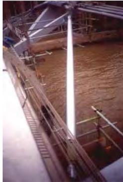
Figura 4 Amortiguadores colocados en pilas Puente Milenio
