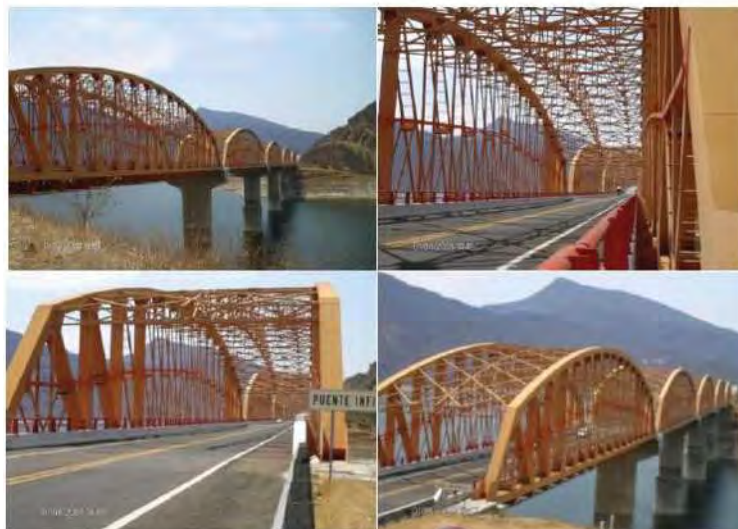
Figura 1.5.1a Puente Infiernillo II ubicado en el estado de Michoacán México. Tomado de Galván (2008).
