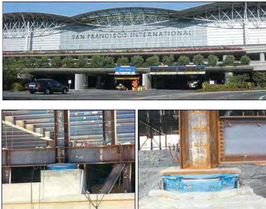
Figura 1.4.3 Aeropuerto internacional de San Francisco (2003) aislado con péndulos de fricción. ( http://www.earthquakeprotection.com/buildings.html )
