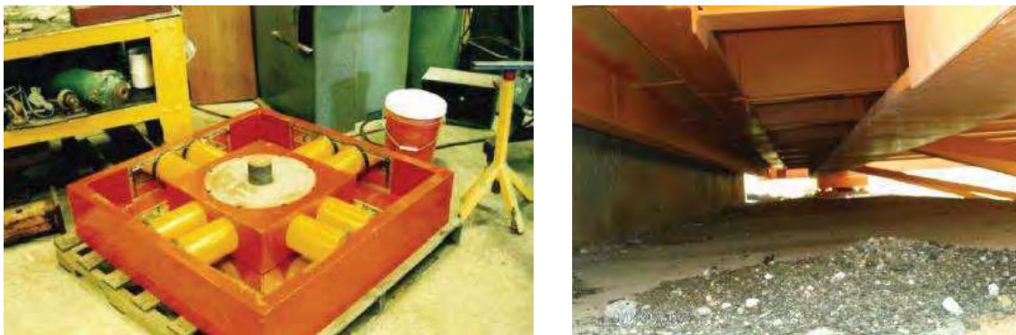
Figura 5.2.6 Aislador tipo multirrotacional colocado en el puente Infiernillo II. (Tomada de: Galván, 2008).
