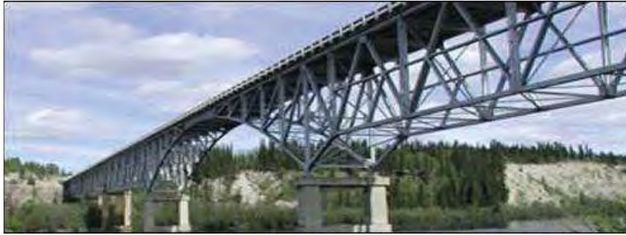
Teslin puente sobre el río, Yukon, Canadá.
