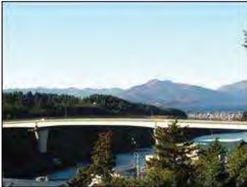
Puente Alaska cerca de isla Kodiak.
