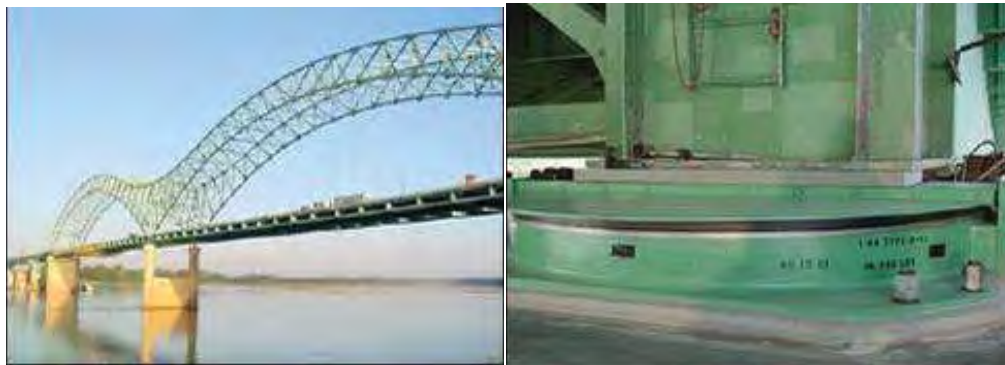
Figura 1.5.4 Puente I-40 Tennessee aislado mediante un sistema de péndulos de fricción. ( http://es.wikipedia.org/wiki/Archivo:GG-ftpoint-bridge-2.jpg )
