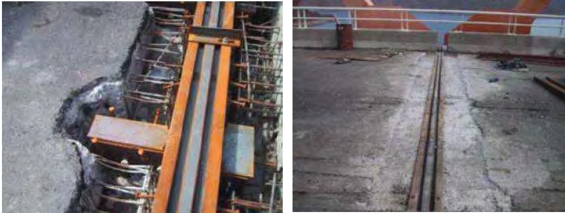
Figura 5.2.5 Juntas de dilatación del puente Infiernillo II. (Tomada de: Galván, 2008).
