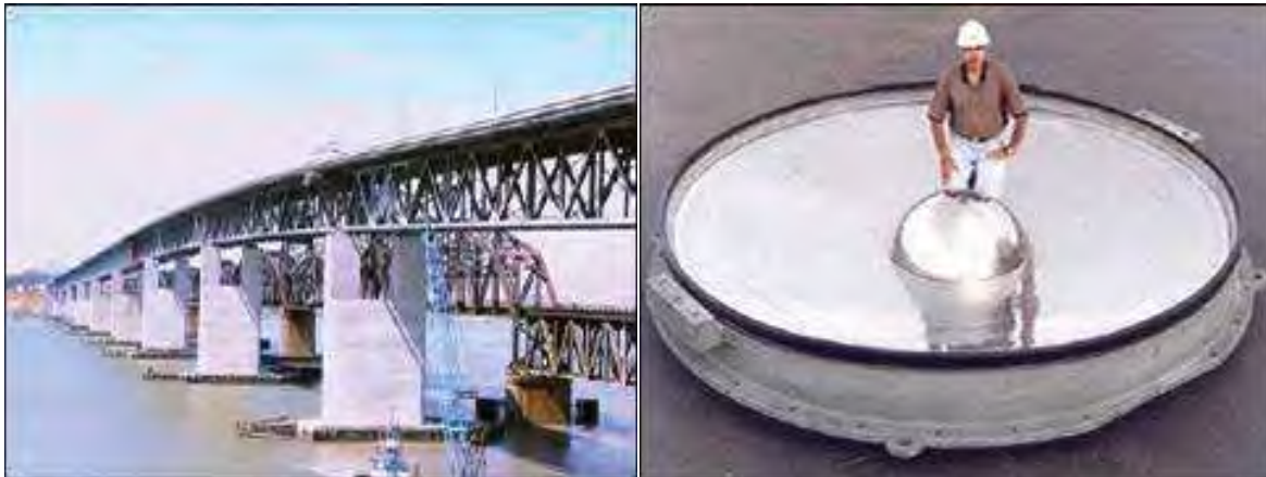
Figura 1.5.5 Puente Benicia-Martínez California aislado mediante péndulos de fricción. ( http://www.earthquakeprotection.com/benicia_martinez_bridge.html )
