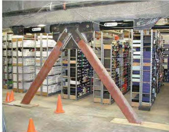
Figura 1.2.7 Aplicación de dispositivos viscosos en un edificio de concreto. Tomado de Hussain et al. (2009).
