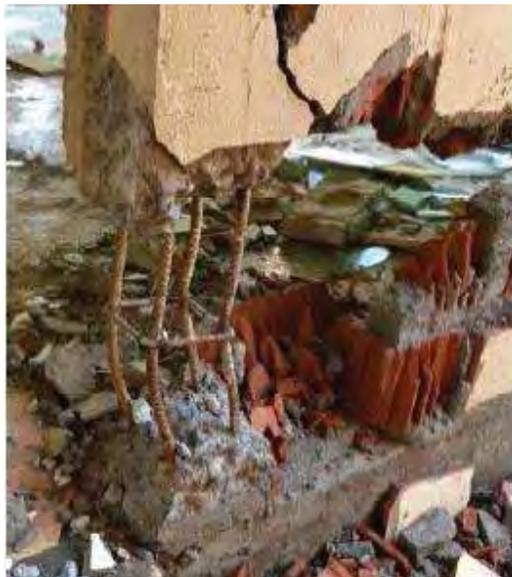
**Figura 1.5** Ausencia de confinamiento en los extremos de los castillos (tomada de Brzev y otros, 2010)
