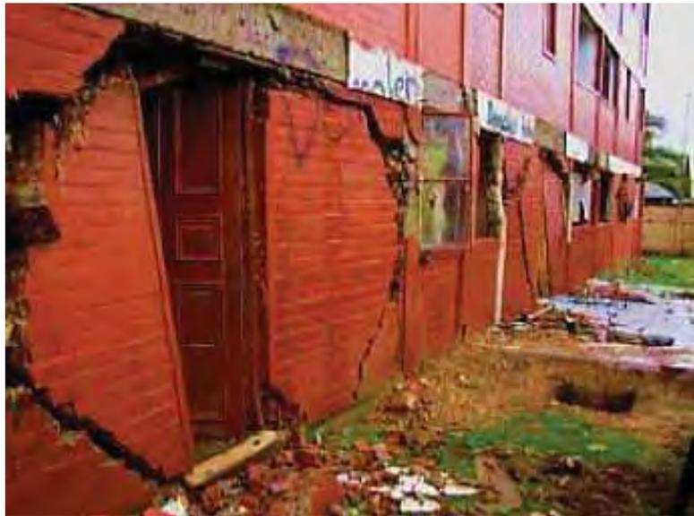
**Figura 1.3** Daño generalizado y formación de piso suave en planta baja de una edificación de tres niveles (tomada de Brzev y otros, 2010).
