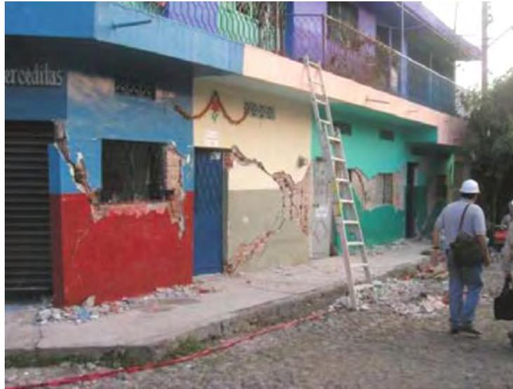
**Figura 1.4** Patrón de agrietamiento típico debido a cortante observado en viviendas dañadas por el sismo de Tecomán del 21 de enero de 2003 (tomada de Klingner, 2004).
