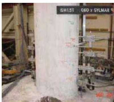
DS-1 Grietas por flexión
