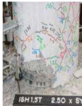
DS-5 Falla inminente, agrietamiento hacia el núcleo del concreto
