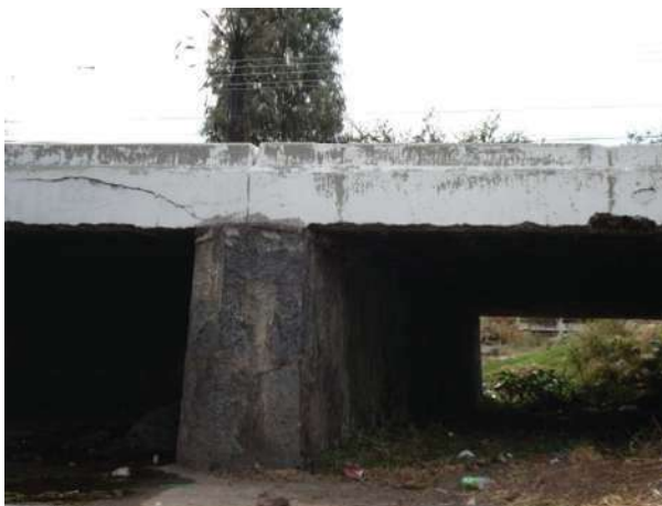
Puente Palo Alto IV
