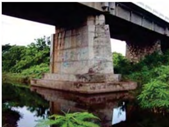
Figura 1.16 Puente tradicional construido antes de la década de 1980, soportado por pilas tipo muro y con una alta resistencia sísmica en ambas direcciones.
