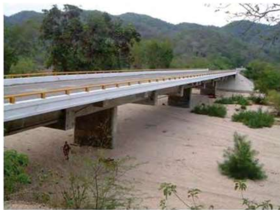
Figura 1.10 Pila tipo muro. Tomado de Jara (2010).
