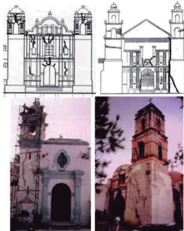
Imagen 2.13. Agrietamiento típico observado en las iglesias de Oaxaca (izquierda) y Puebla (derecha, Peña y Meza, 2010).
