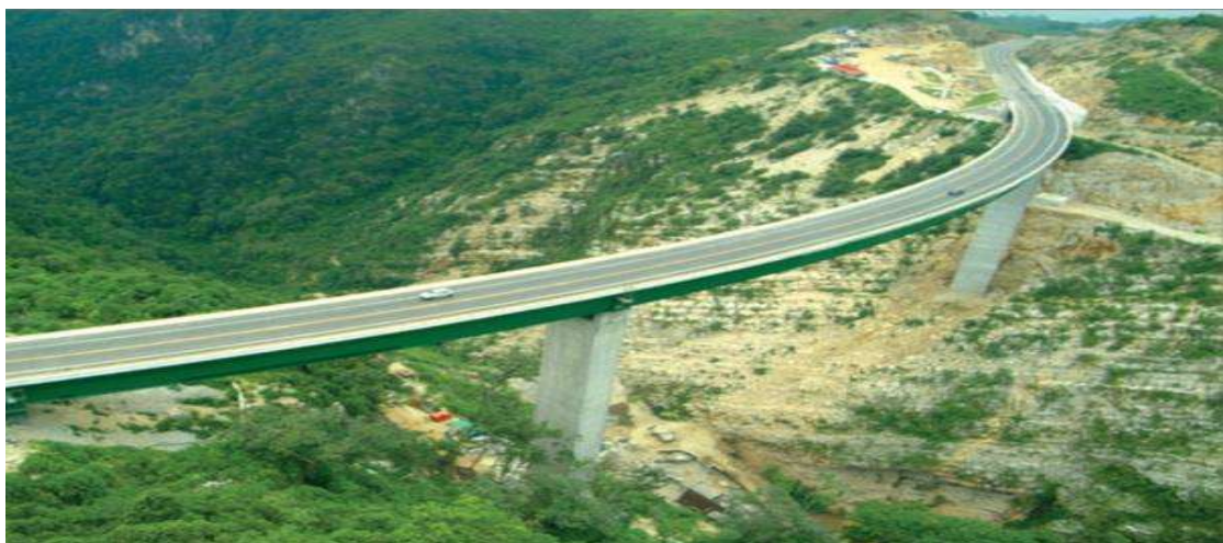
m) puente San Cristóbal
