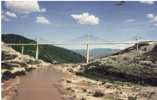
a) Puente Mezcala
