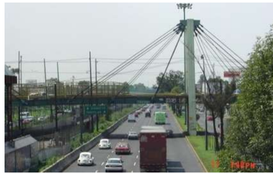
b) Puentes tipo de la avenida Zaragoza
