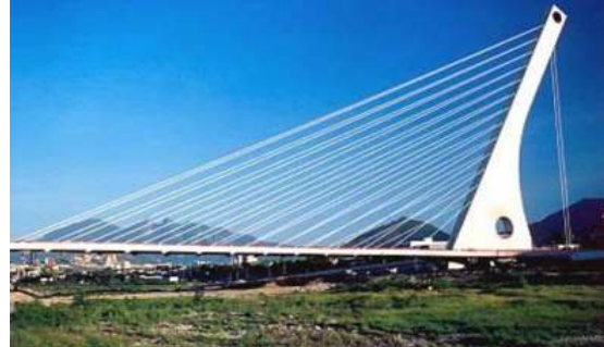
j) El Puente Viaducto de la Unidad
