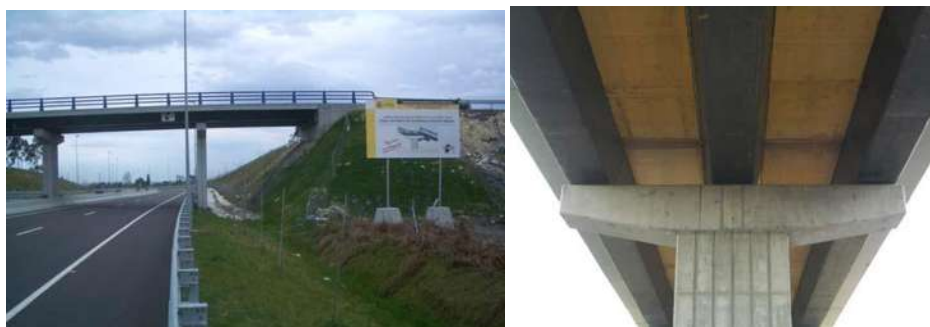
Figura I-8 Primer Puente de Materiales Compuestos Construido en España. (De Diego Villalón, et al., 2008)
