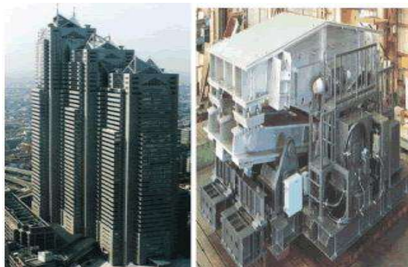
Figura I-16 Torre Park Shinjuku donde se instaló un sistema de control híbrido con amortiguador de masa. http://www.revista.unal.edu.co/index.php/dyna/article/view/1742/11580
