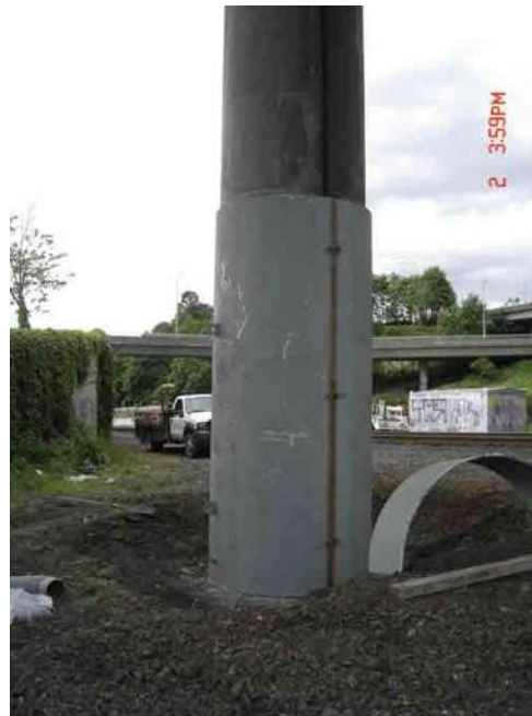
Figura III-12 Encamisado de acero parcial en la columna. http://www.wsdot.wa.gov/Projects/15/SSeattleSeismic/Photos
