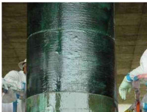
Figura I-10 Aplicación de FRP a una columna circular manteniendo la sección original. http://rbconspro.wordpress.com/2009/11/14/reforzamiento-estructural-con-fibras-de-carbono/
