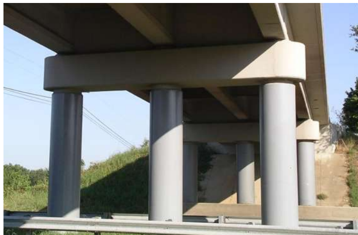
Figura III-1 Encamisado de acero aplicado en toda la longitud de la columna. (Padgett, 2007)
