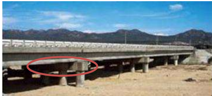
Figura III-4 Cabezales de concreto reforzado. http://www.cicmexicali.org/socios/publicacion/297
