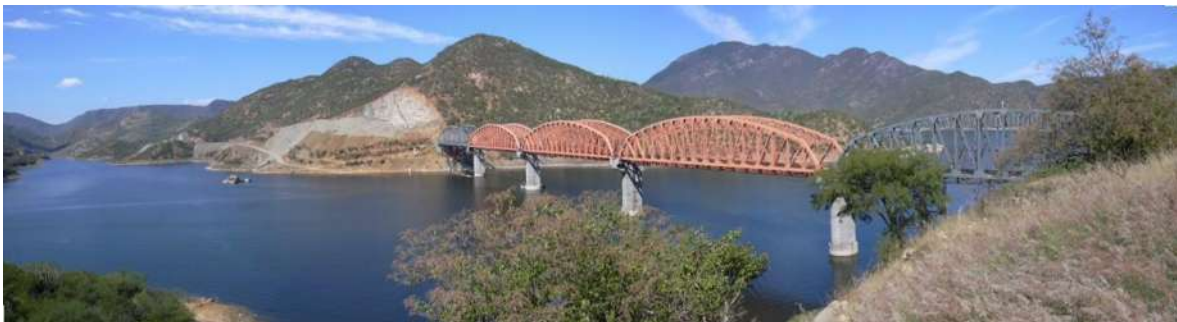
Figura I-12 Puente Infiernillo II ubicado en la carretera Nueva Italia – Lázaro Cárdenas en el estado de Michoacan. http://static.panoramio.com/photos/original/6591528.jpg
