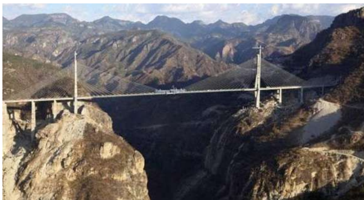
Figura I-1 Puente Baluarte el más alto del mundo. Está ubicado en la carretera Mazatlán – Durango, México, Cuenta con 1124m de longitud soportados por 152 tirantes de acero. http://www.bieninformado.mx/Inicio/index.php/nacion/item/126-puente-baluarte-el-m%C3%A1s-alto-del-mundo
