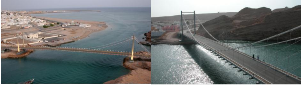
Figura I-15 Puente “Khor al Batah Omán” que se ubica en el Sur Omán y que consta de un sistema que consta de 3 tirantes activos a cada lado del puente. http://www.sbp.de/es/build/sheet/1536-Stra%C3%9Fenbr%C3%BCcke_Khor_al_Batah_Oman.pdf .
