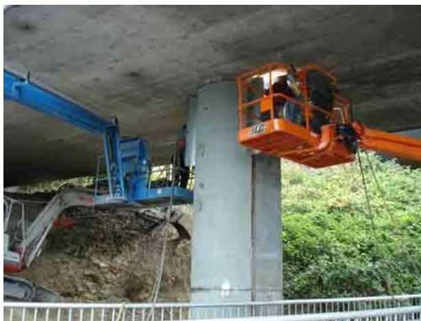
Figura III-16 Espacio vertical del encamisado de acero. http://www.wsdot.wa.gov/Projects/15/SSeattleSeismic/Photos
