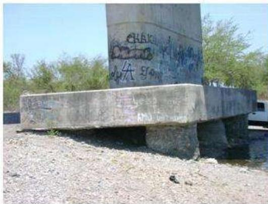
Figura 1.13 – Socavación en la pila 3 de puente Ignacio Chávez (Jara et al, 2011a)
