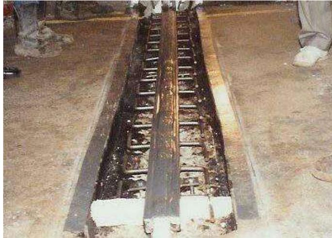
Figura 2.20 – Reemplazo de junta de expansión (Brown Company)
