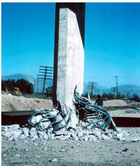
Figura 2.4 – Columna de concreto reforzado dañada durante el terremoto de San Fernando, 1971 (Shin, 2012)
