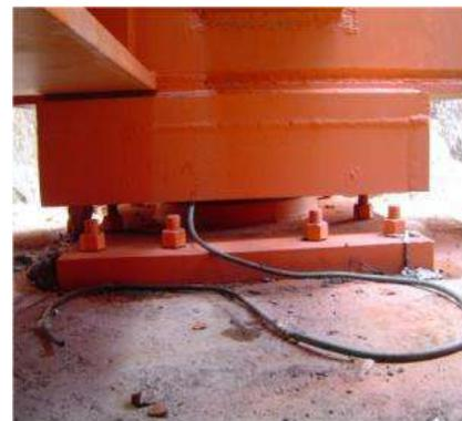
Figura 2.14 – Izquierda, Puente Infiernillo II (Memoria de obras SCT, 2002). Derecha, aislamiento sísmico utilizado en una pila del puente (Jara et al, 2011)
