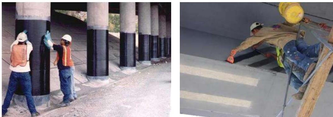
Figura 2.5 – Refuerzo con fibra de carbono. (Jara et al, 2011a)
