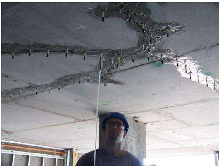
Figura 2.9 – Inyección con resina. (<http://www.ecosat.cl/images/repuracion-fisuras2.jpg>)
