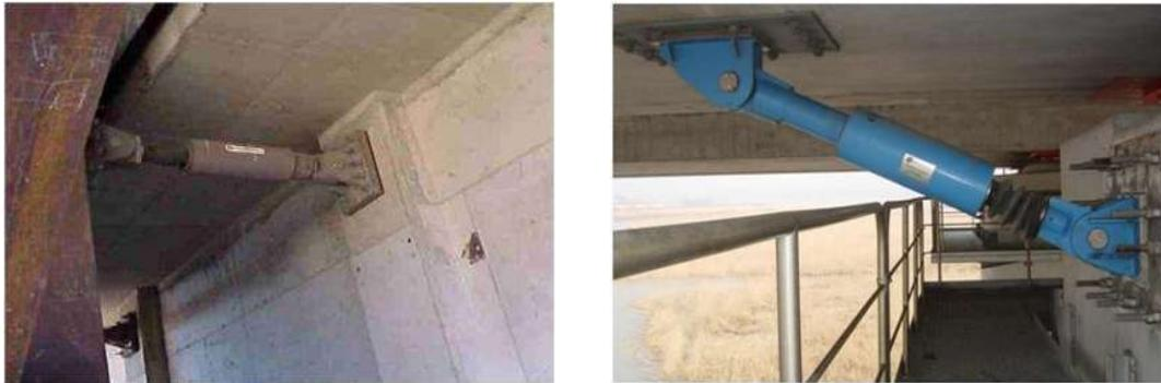
Figura 2.15 – Disipadores de energía dependientes de la velocidad. (Jara et al, 2011)
