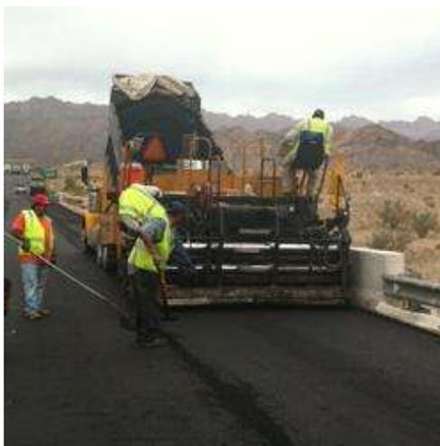
Figura 1.1 – Re-encarpetamiento de puente (<http://paginas.seccionamarilla.com.mx/asfaltos-y-agregados-industriales/venta-de-asfalto/baja-california/mexicali/-/cerro-prieto/>)
