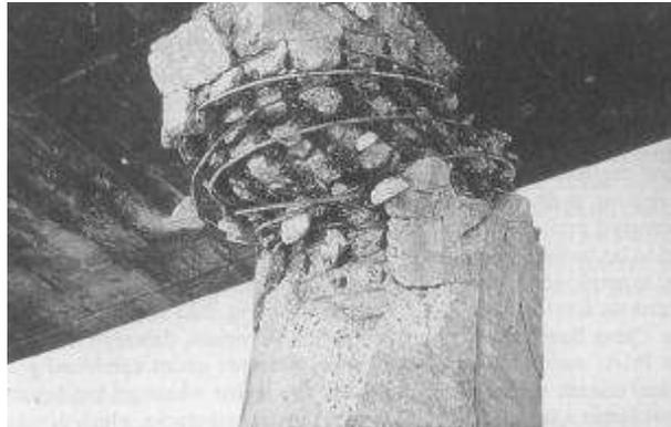
Figura 1.16 – Falla por cortante dentro de una región de articulación plástica durante el sismo de San Fernando de 1971. (Priestley et al, 1996)
