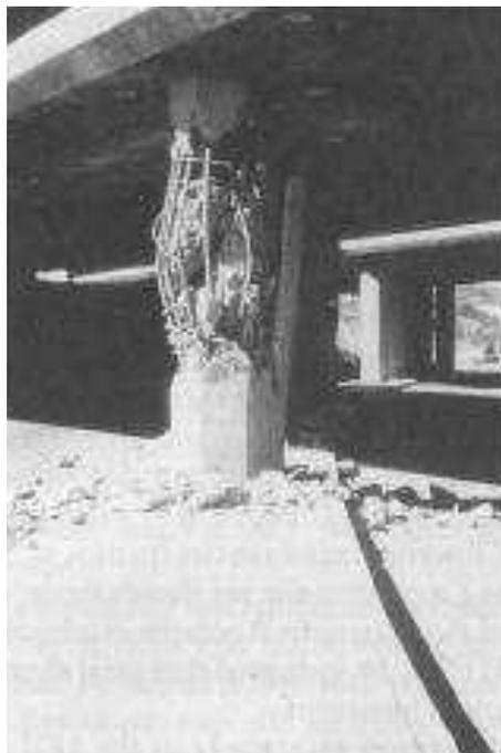
Figura 1.17 – Falla por cortante fuera de una región de articulación plástica durante el sismo de San Fernando de 1971, se observa la escasa cantidad de acero transversal. (Priestley et al, 1996)
