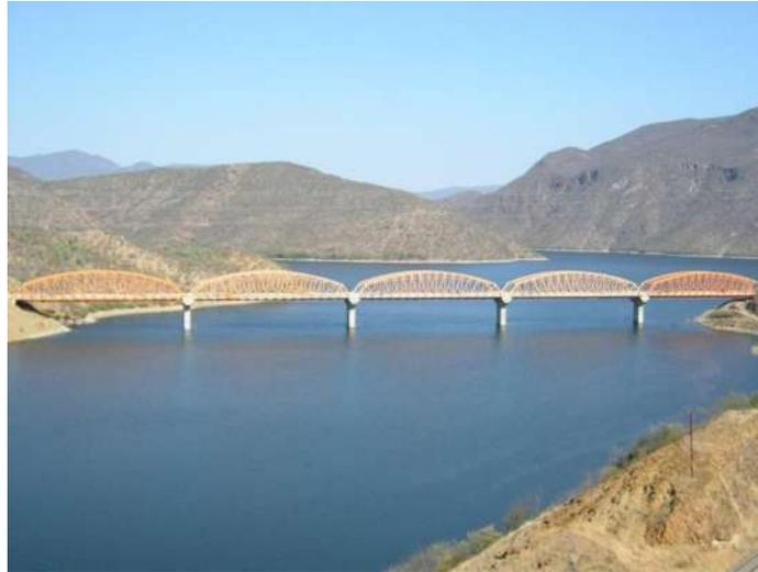
Figura 1.3 – Puente Infiernillo II (Puente con pilas de diferente altura o irregular)
