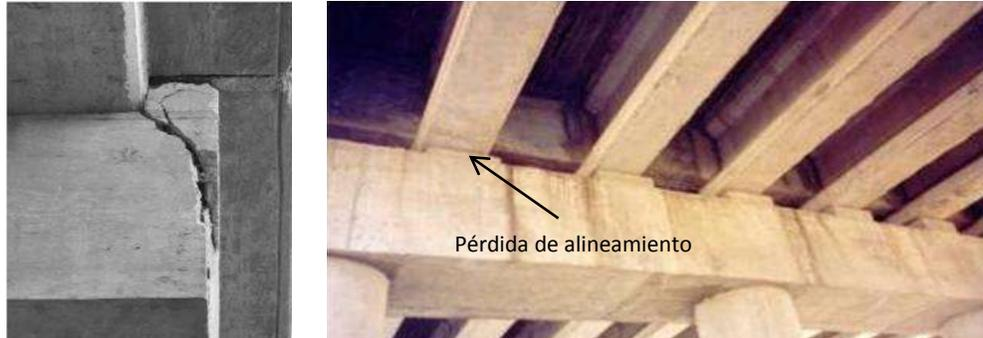
Figura 1.9 – Daño en el puente Manzanillo (Alcocer et al, 2003)
