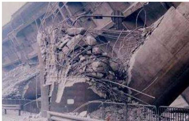
Figura 1.15 – Falla prematura por cortante en el Viaducto Fakue durante el temblor de Kobe. (Jara et al, 2011a)
