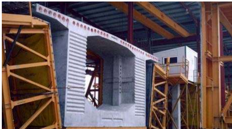
Figura 1.2.c Dovela en el Parque de Prefabricación.
