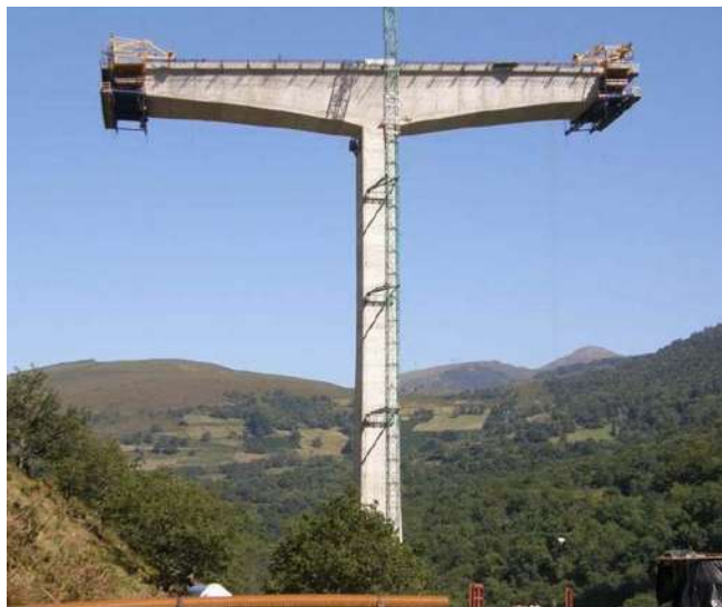
Figura 1.1.a Proceso constructivo mediante Voladizo Balanceado.
