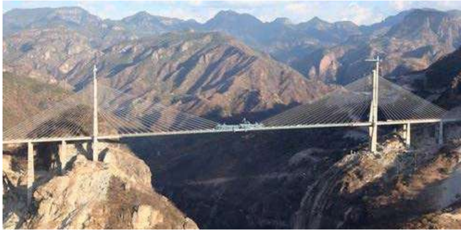
Figura 1.3.a PUENTE BALUARTE BICENTENARIO, en la carretera Mazatlán-Durango, sobre la Sierra Madre Occidental.
