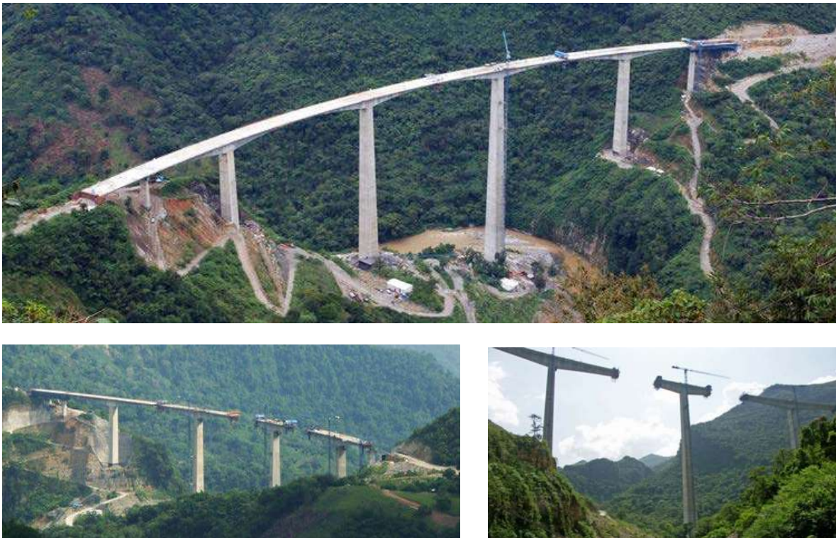
Figura 3.a Puente San Marcos, Autopista Mexico-Tuxpan.
