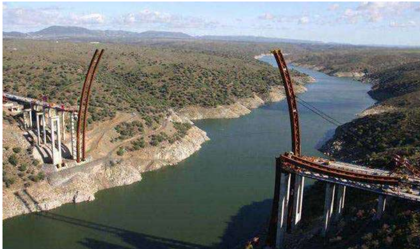
Figura 1.4.c Construcción por abatimiento, puente "Arcos de Alconétar".
