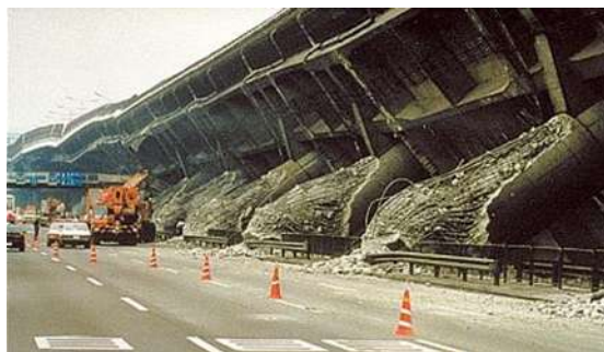
Figura 1.2 Viaducto Hanshin, Kobe, Japón.
