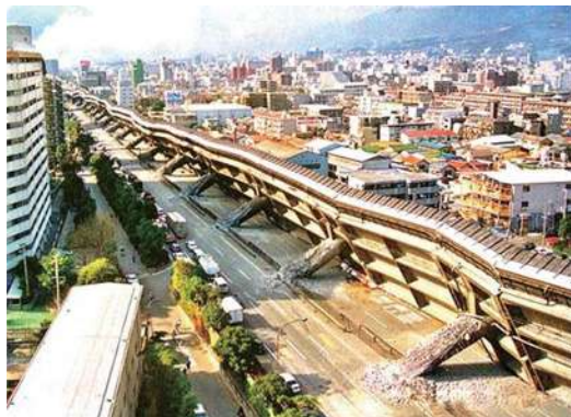
Figura 1.1 Viaducto Hanshin, Kobe, Japón.
