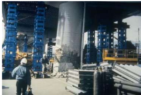
Figura 1.8 Pila del Viaducto Hanshin.
