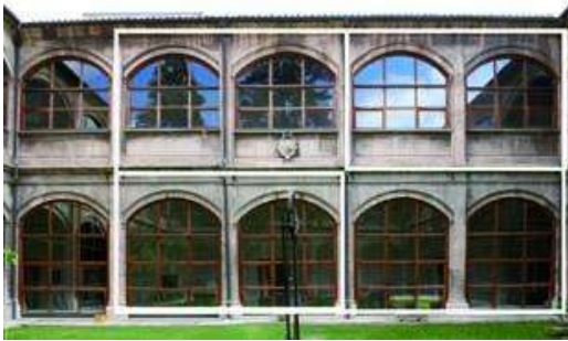
Imagen 2.3a Claustro con rectángulos en sentido horizontal
