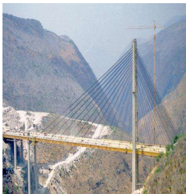
b) Puente Barranca del Cañón
