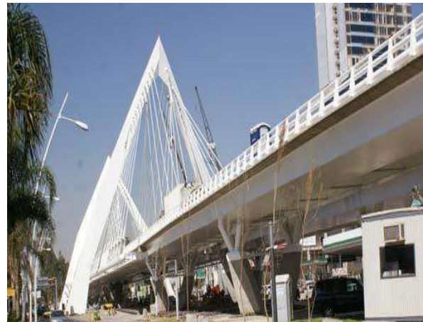
Figura 2.2 Puente Matute Ramus. Tomada de: http://www.obrasweb.mx/media/2011/08/09/puente-matute-remus-seis-no-publicar.jpg .
