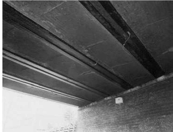
Figura 2.9 Puente ferroviario de la calle King, Mold, Reino Unido. Tomada de: Hollaway L.C. and Cadei J., 2002.
