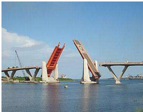
Figura 2.3 Puente Albatros. Tomada de: http://www.altonivel.com.mx/23548-4-grandes-proyectos-de-infraestructura-del-sexenio.html .
