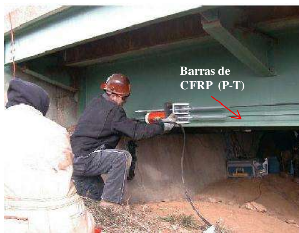
Figura 2.13 Puente en el Condado de Guthrie, Iowa, en la carretera estatal 141. Tomada de: Brent M. Phares, Terry J. Wipf, F. Wayne Klaiber, et al; 2003.
