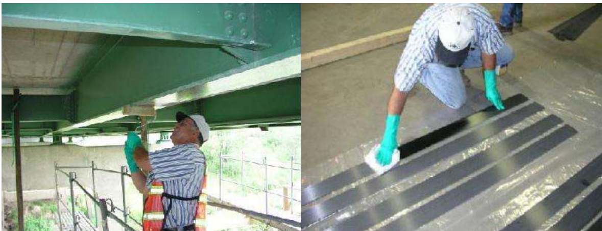
a) Preparación de la viga de acero y la placas CFRP
