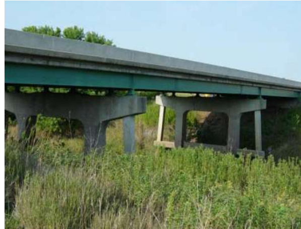
Figura 2.14 Puente en el Condado de Pottwattamie, Iowa, en la carretera estatal 92 . Tomada de: Brent M. Phares, Terry J. Wipf, F. Wayne Klaiber, et; 2003.
