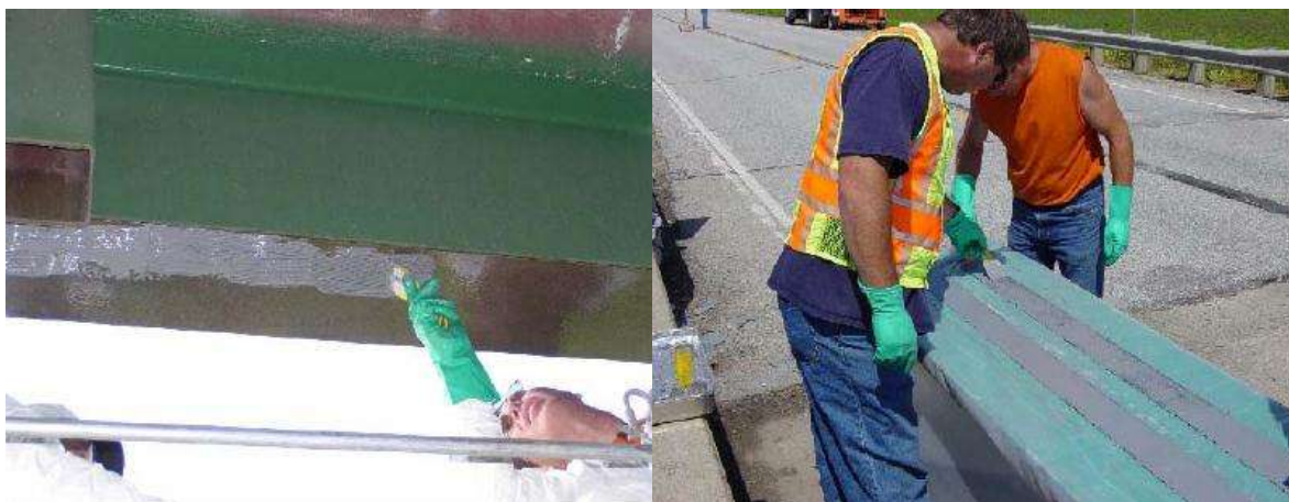
b) Colocación del adhesivo en la superficie de acero y en las placas CFRP
