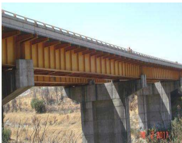
Figura 2.4 Puente Barranca Honda. Tomada del IMT(Publicación Técnica No. 387 )
