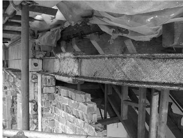
Figura 2.17 Viga principal curvada, Nottingham, Reino Unido. Tomada de: Hollaway L.C. and Cadei J., 2002.
