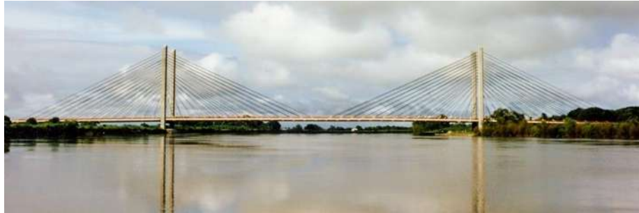
Figura 3.1. Puente atirantado sobre el río Papaloapan 2
