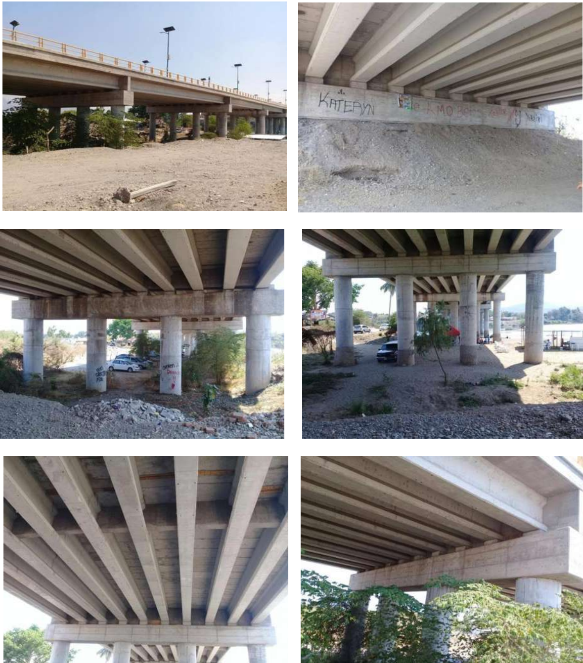
Figura 92. Puente Miguel Alemán reconstruido.
