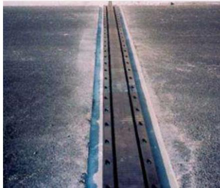
Figura 21.-Junta entre tableros de un puente
