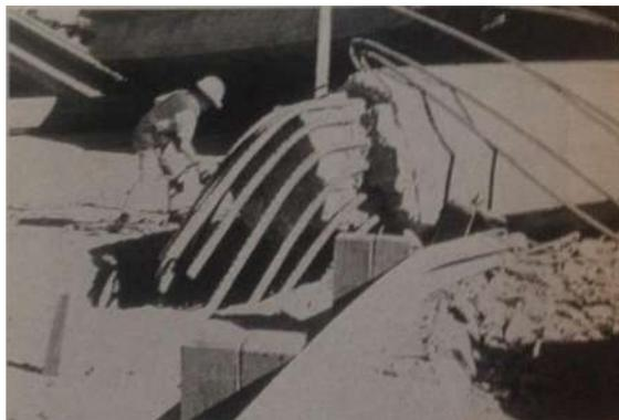
*Figura 3.-Falla en la zona de anclaje (Jeffrey G. et. al, 2012).*
