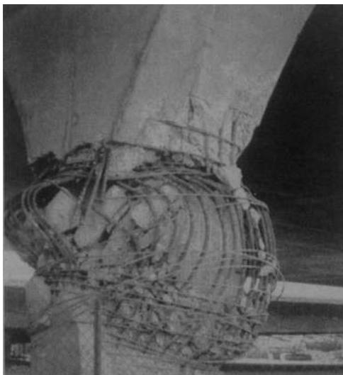
*Figura 1.-Falla por compresión del concreto confinado (Jeffrey G. et. al, 2012).*
