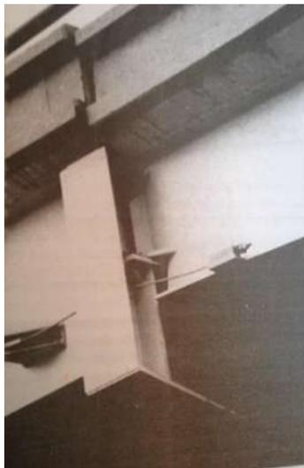
Figura 28.-Sujetador simple (ACI 341.2R., 2003).
