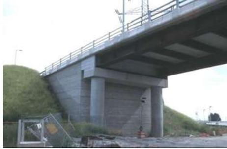
Figura 23.-Estribo del extremo de un puente
