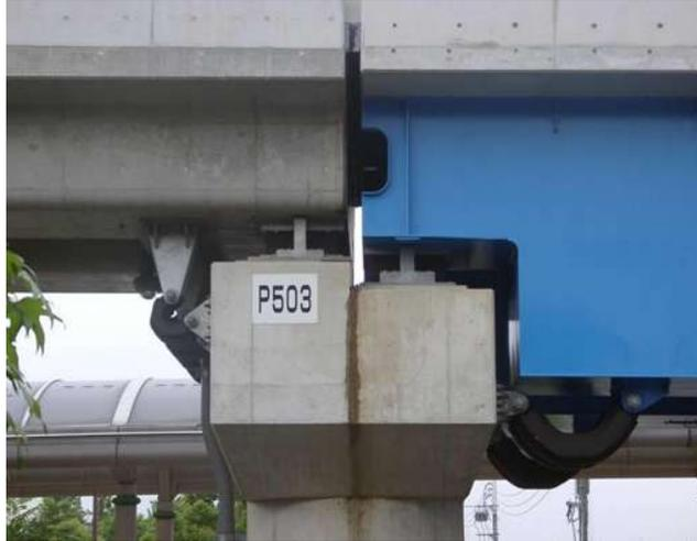
Figura 29.-Sujetadores con disipación de energía (Tomado de:[http://www.amivtac.org/assets/files/document/1834\\_Presentacion\\_M\\_Jara.pdf](http://www.amivtac.org/assets/files/document/1834_Presentacion_M_Jara.pdf), 2016).
