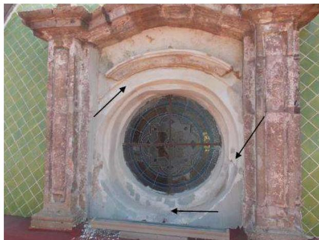
**Figura 15. Comparación entre los estados de esfuerzo encontrados en el modelo y la comparativa con los daños observados en el templo. Nuñez et al. 2016**
