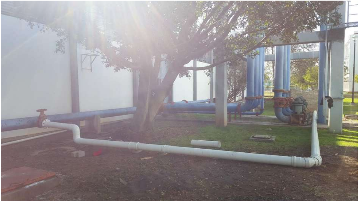
Figura 71.- Panorámica de la instalación de la línea de alimentación de flujo del modelo hidráulico.
