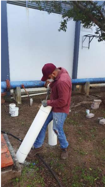
Figura 67.- Preparación de la espiga de forma manual para la unión de tramos de tubería
