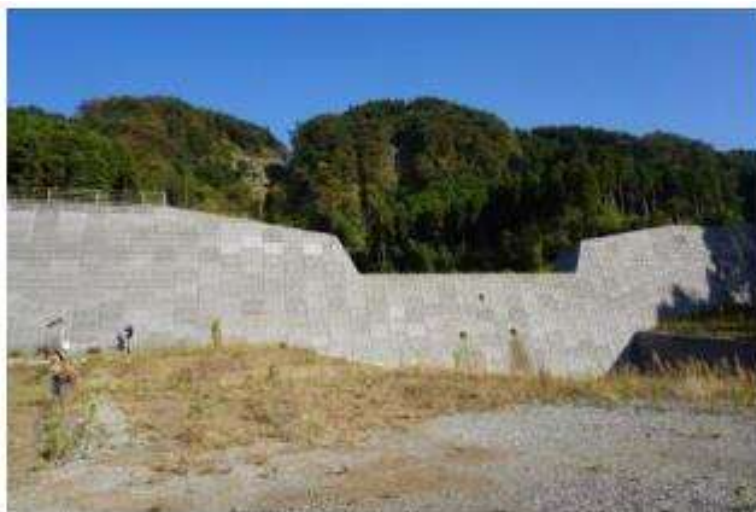
Figura 129. Ejemplo de represa SABO para el control de flujos de detritos en Minami-Aso Village (Kumamoto). Recuperada de: Villacorta, S.; Huaréz, C. & Colina, C., 2016.
