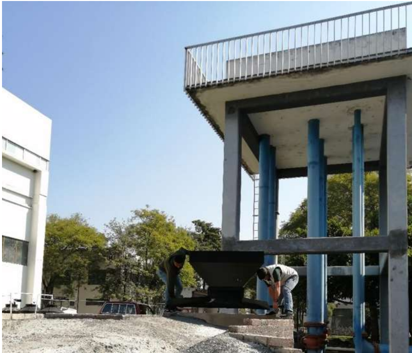
Figura 77. Colocación de la tolva para descarga de material pétreo sobre el modelo hidráulico.
