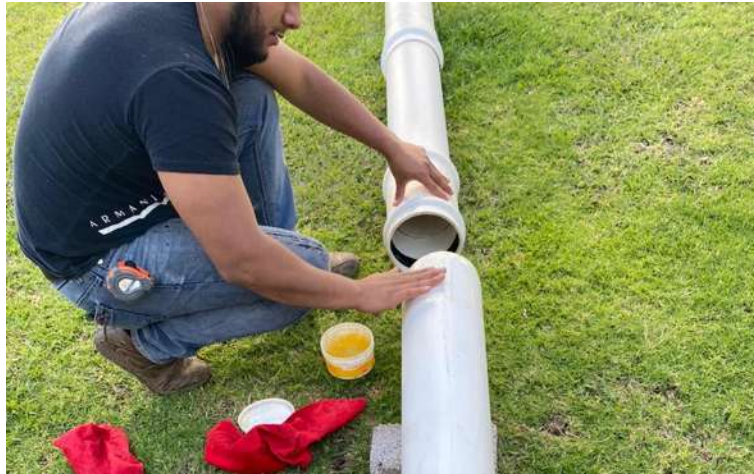
Figura 69.- Lubricación de los tramos de tubería para su respectiva unión.
