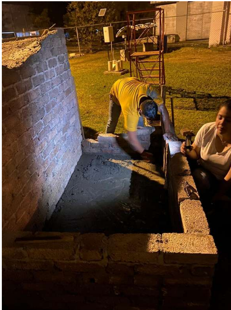
Figura 70.- Construcción de tanque de disipación de energía, con apoyo de compañeros del Departamento de Hidráulica.
