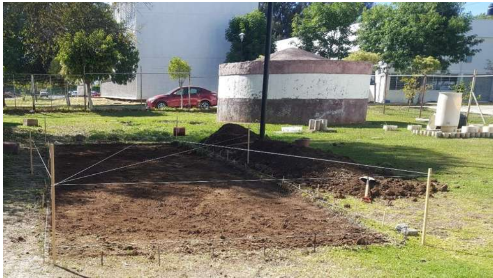
Figura 17.- Zona de construcción de la modelo hidráulico nivelada.
