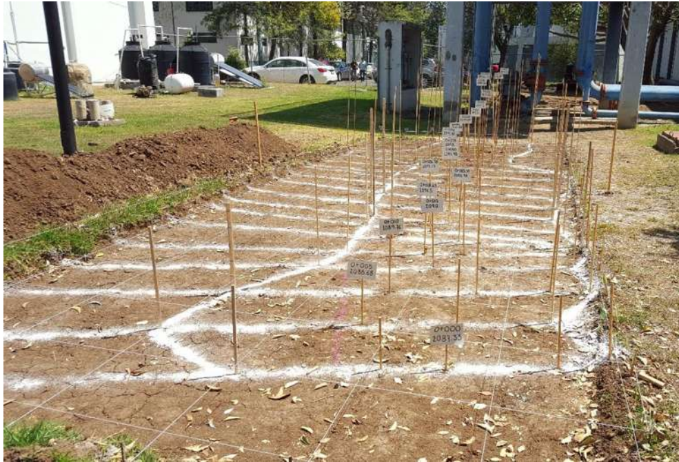
Figura 43.- Replanteo y colocación de cotas de las secciones transversales en escala 1:10.
