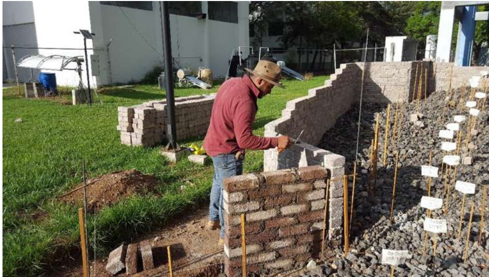
Figura 45.- Junteado de tabicones para la construcción de los contornos del modelo hidráulico.
