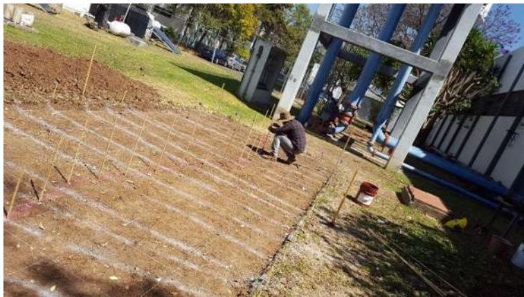
Figura 20.- Replanteo y colocación de cotas del cauce principal.
