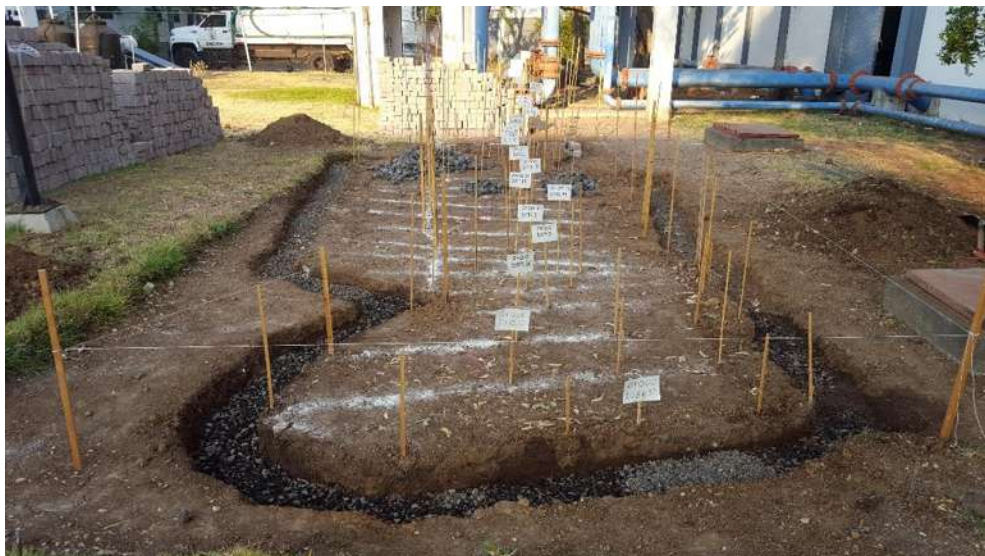
Figura 44.- Mejoramiento mecánico con grava de \frac{3}{4} " del suelo donde se desplantarán los muros.
