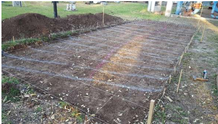
Figura 19.- Replanteo de secciones transversales y centro de línea del cauce principal.
