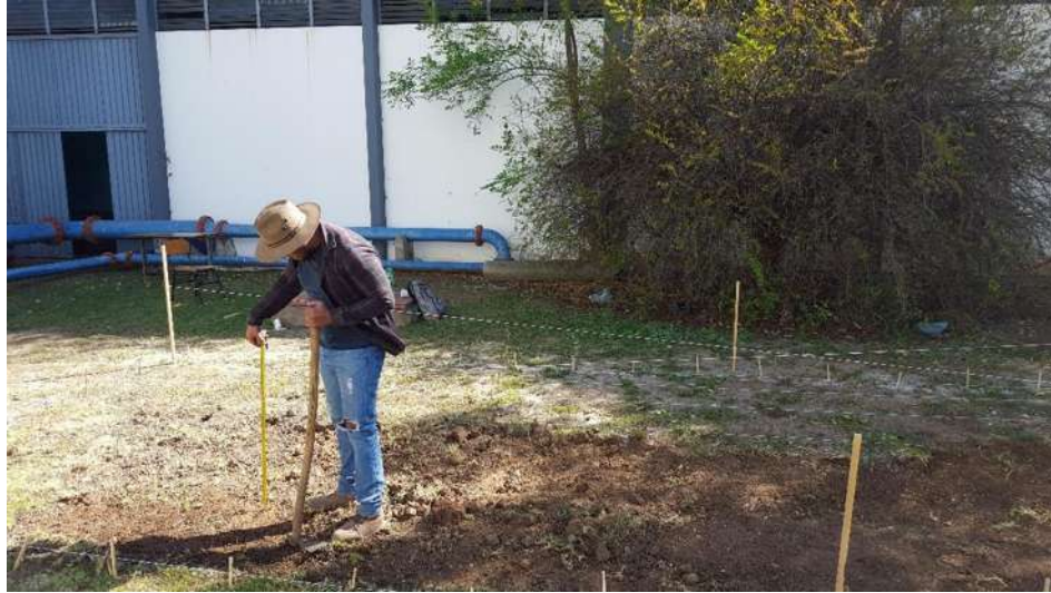
Figura 16.- Despalme y nivelación de la zona de construcción del modelo hidráulico.
