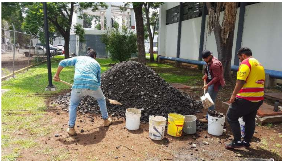
Figura 46.- Acarreo de material filtro por medios manuales y con apoyo de alumnos que realizan servicio social en el Departamento de Hidráulica.
