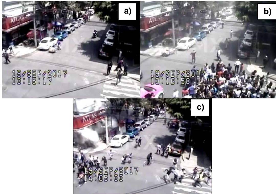
Figura 1.6 Edificio ante el evento sísmico del 19 de septiembre de 2017, ubicado entre el cruce de las calles Medellín-San Luis Potosí: a) antes del sismo, b) después del sismo, y c) colapso estructural
