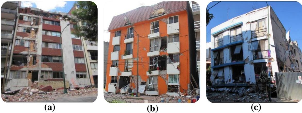
Figura 1.3 - Edificios con configuración de planta baja débil que colapsaron durante el sismo del 19 de septiembre de 2017: (a) Edificio de 6 niveles ubicado en Patricio Sanz No.37, (b) Edificio de 5 niveles ubicado en Paseo de las Galias 47 y (c) Edificio de 4 niveles ubicado en Saratoga 714 (Fotos de Jorge Ruíz-García)
