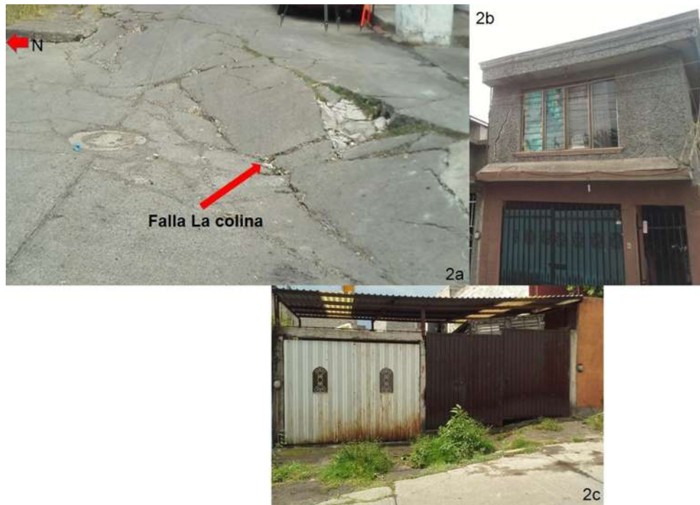
Figura 2. Se aprecia la calle Halcón afectada por la falla La colina (a), (b) corresponde a casa identificada como afectada por la subsidencia diferencial, (c) ambas ubicadas en el bloque de techo de la falla La Colina.
