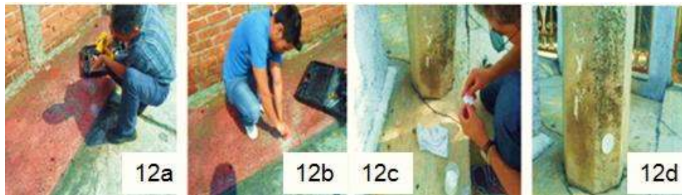
Figura 12. En las fotografías a y b se aprecia la colocación de taquetes y pijas, en donde fueron ubicados los tripies con reflectores. En la calle Halcón entre los puntos de control se tomó de referencia un poster imagen c y d en donde se colocó reflector de etiqueta.
