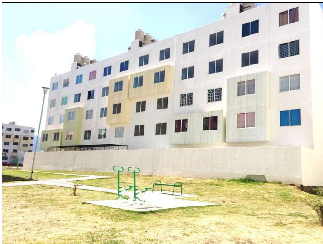
Figura 33.- Edificio con más del 50% de viviendas deshabitadas en el fraccionamiento Villas del Pedregal.
