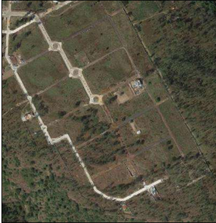
Figura 25.- Lote Baldío de tipo residencial, visto espacialmente.
