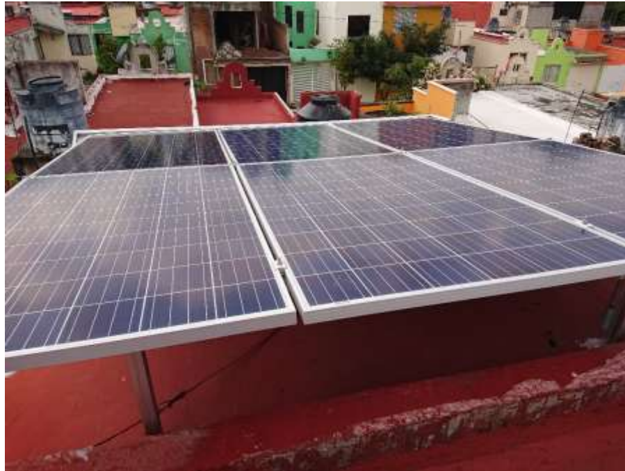
Figura 16. Instalación fotovoltaica de 1.620 Kw
