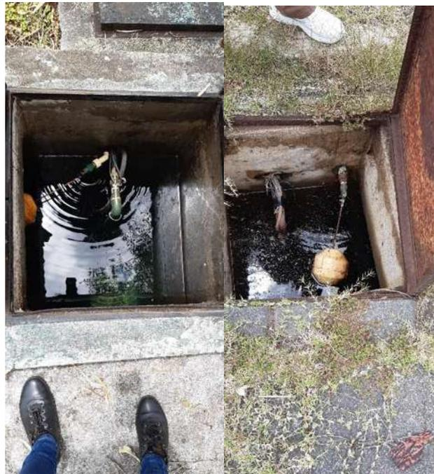
*Figura 53. A) Cisterna en buen estado de mantenimiento. B) Cisterna en mal estado de mantenimiento.
