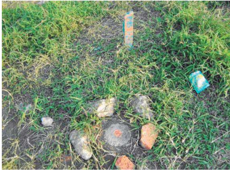
Figura 7 Elementos para marcar los puntos de referencia en la poligonal abierta y en las secciones transversales.
