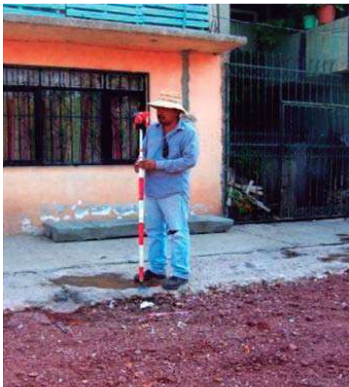
Figura 8 Colocado del prisma para levantamiento de puntos de la topografía.
