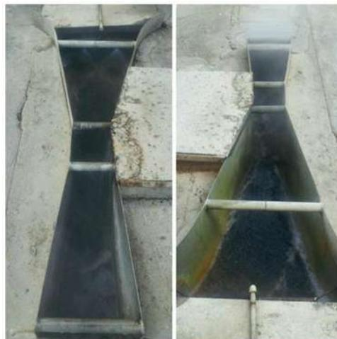
**Figura 13.** Canal Parshall donde se obtiene el efluente Alcalino.
