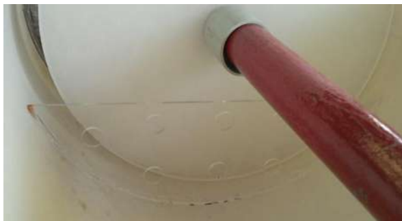
Figura 5.15 Colocación de los separadores de las etapas del reactor.
