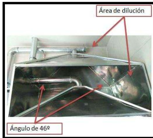
Figura 28. Campana para la captura de las emisiones de la chimenea.
