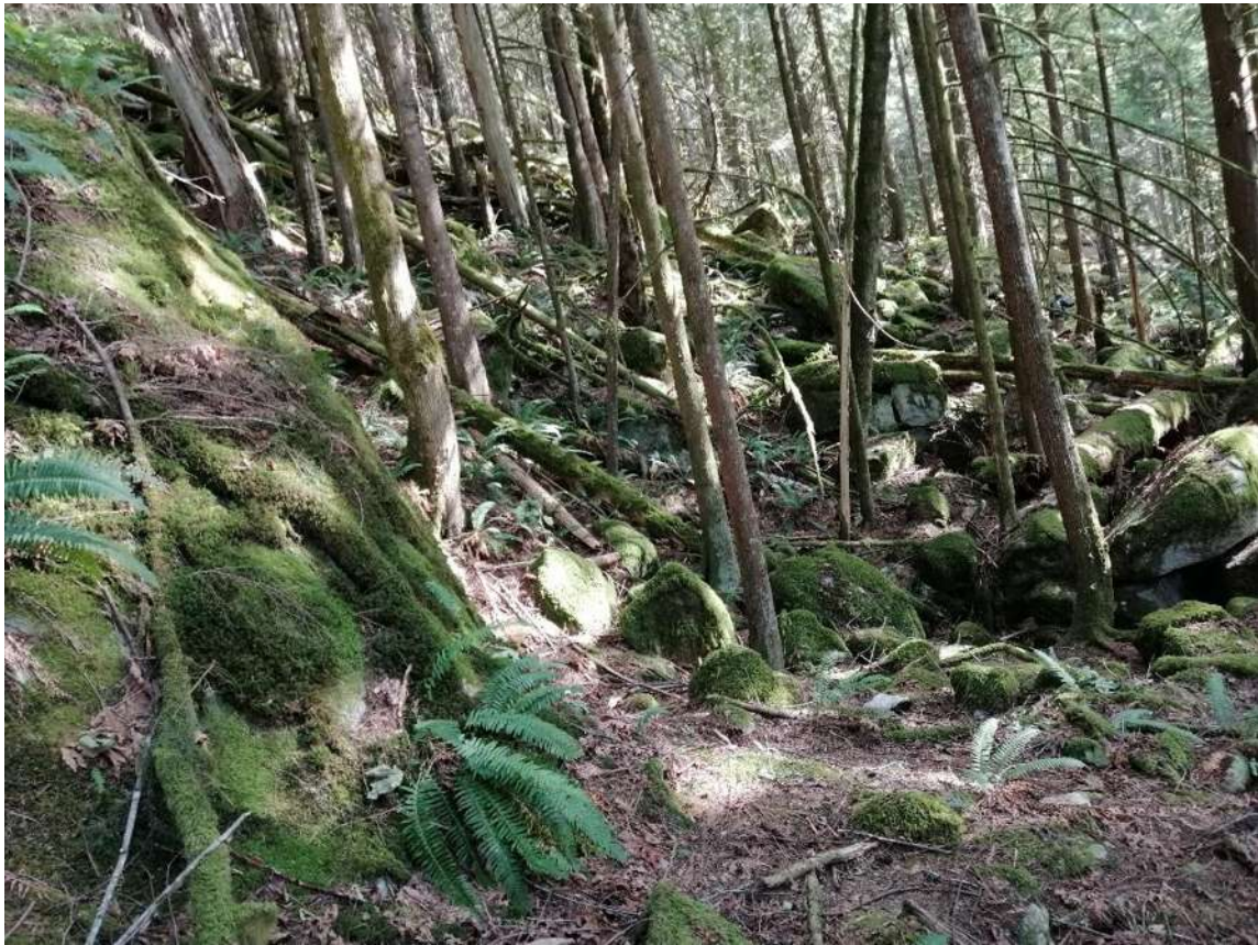
Figura 28. Foto del talud escalonado con un cambio de pendiente importante, sendero relativamente plano, y posteriormente un hundimiento
