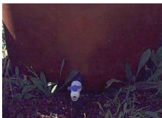
Figura 3.5 Toma del efluente
