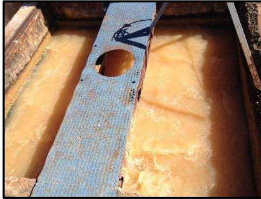
**Figura 1.4.-** Cámara de Mezclado rápido (Coagulación).
