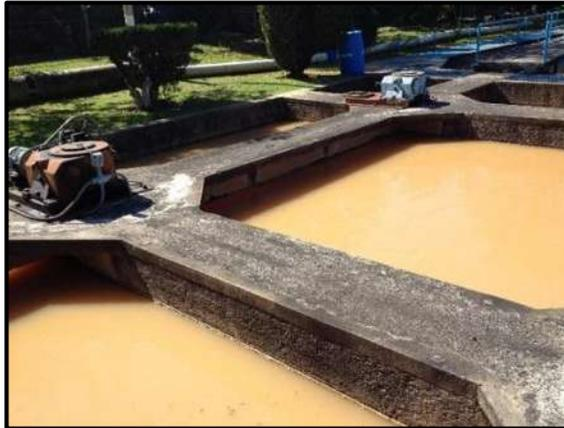
**Figura 1.5.-** Cámara de Mezclado lento (Floculación).
