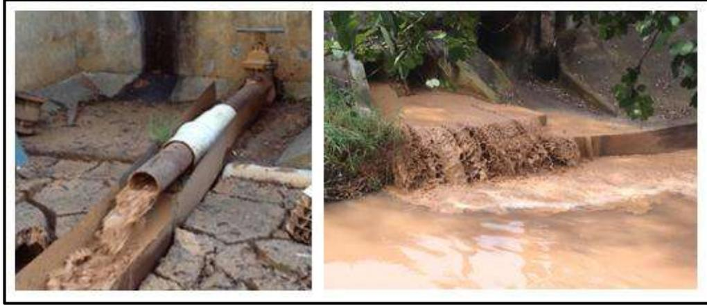
**Figura 1.7.-** Purga de lodos de la planta potabilizadora Vista Bella descargada sobre el río Chiquito de Morelia.
