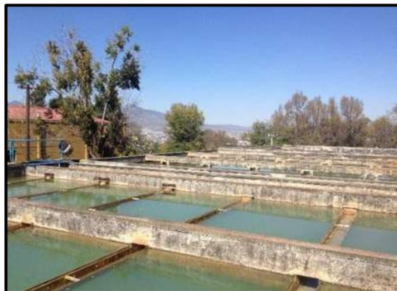
**Figura 1.6.-** Tanques sedimentadores de la planta potabilizadora de Vista Bella.
