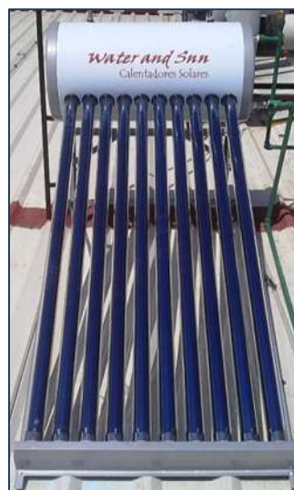
Figura 11. Colector solar tipo tubos de vacío
