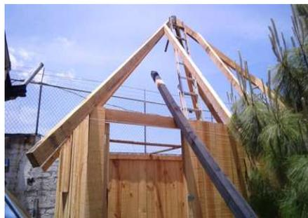
*Figura 39: Construcción del techo de la cabaña*
