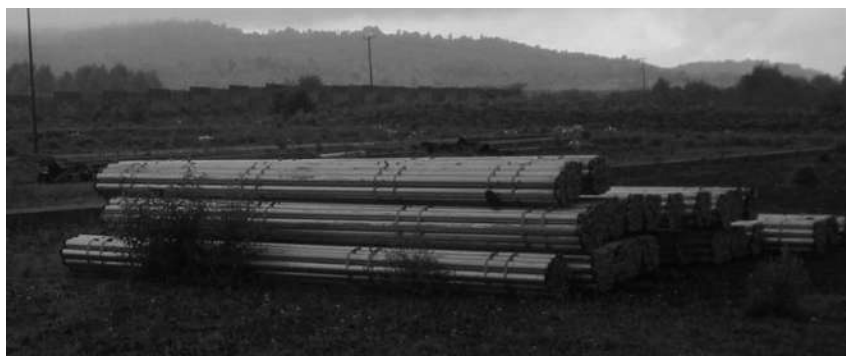
Figura VII Tubería de 4" de Galvanizado que se adquirió para la línea de conducción de la comunidad de Sevina al Campus Universitario quedo sin uso debido a la cancelación de la obra. Fuente: Foto tomada por CRS.
