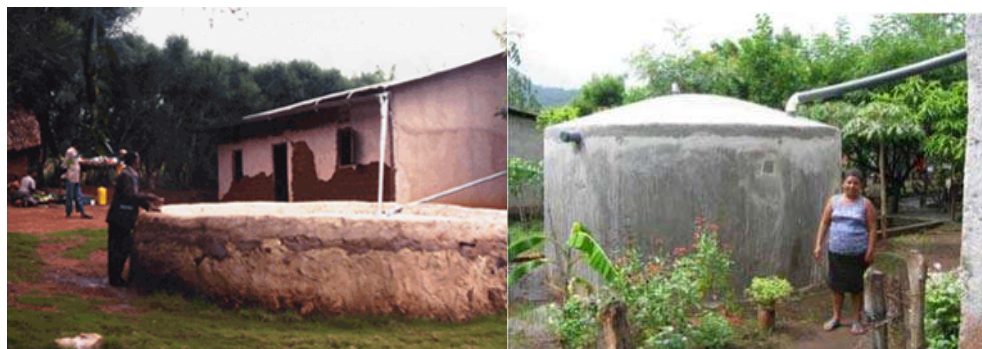
Figura 1.16 Sistemas de captación de agua de lluvia en techos de lámina, conducción y almacenamiento. Nicaragua. Fuente: CIDECALLI – CP.
