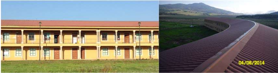
Figura XII Parte de la fachada frontal del edificio A (imagen derecha), caballete de la cubierta del edificio “A”, del campus Pichataro, área de cubierta es de 2000 m 2 , en cada edificio. Fuente: Foto tomada por CRS
