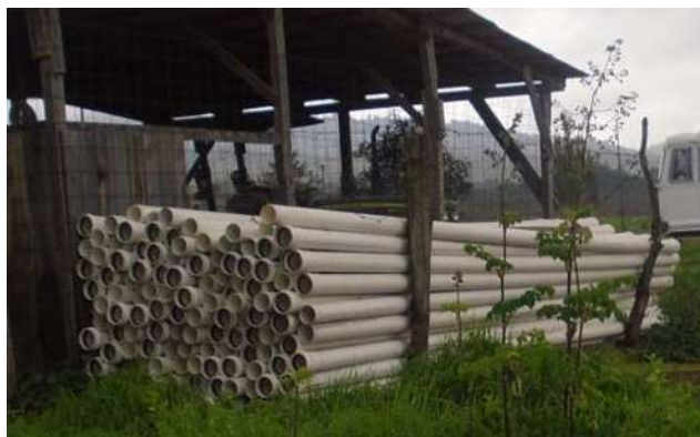
Figura VI Tubería de 4" de PVC que se adquirió para la línea de conducción de la comunidad de Sevina al Campus Universitario quedo sin uso debido a la cancelación de la obra. Fuente: Foto tomada por CRS.
