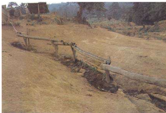
Figura 1.25 Canalejas de madera tradicionales que usaban para conducir agua. Fuente: (Ávila García P., 1996).
