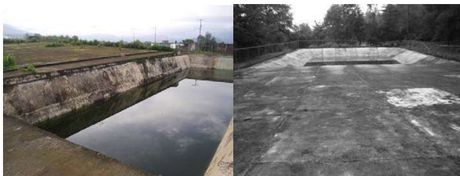
Figura 1.26 Sistema de captación pluvial de tipo pasivo, construidas en los años 60's y 70's, de las comunidades Cheranastico y Urapicho respectivamente. Fuente: Foto tomada CRS.
