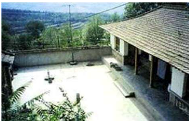
Figura 1.8 El agua es captada en el techo, se almacena bajo el piso y se extrae mediante una bomba de mano. Fuente: www.unep.or.jp .
