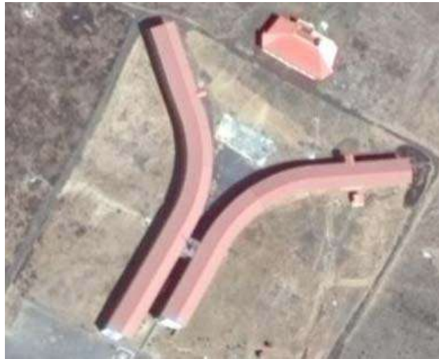
Figura XIII Cubiertas de los edificios “A” y “B”, del campus Pichataro, área de cubierta es de 4000 m 2 , entre los dos edificios.
