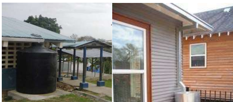
Figura 1.13 Sistema de captación de agua de lluvia básico. Dallas, Texas, en Estados Unidos. Fuente: CIDECALLI – CP.
