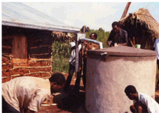
Figura 1.15 Cisterna recolectora de agua de lluvia en Honduras. Fuente: CIDECALLI – CP.
