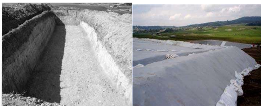
Figura 1.18 Cisterna revestida con geomembrana de PVC en la zona Mazahua. Fuente: CIDECALLI – CP
