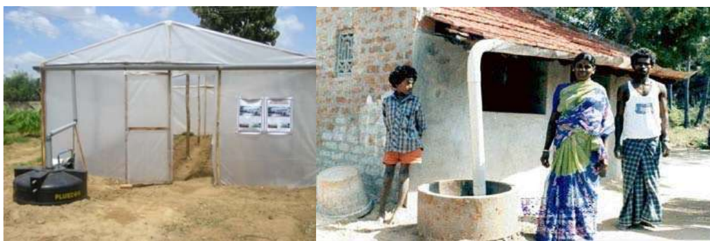
Figura 1.9 Captación de agua de lluvia para recarga de acuífero y riego en invernadero, India. Fuente: www.auick.com .
