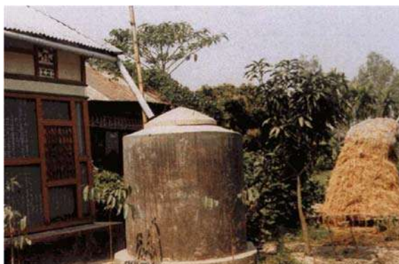
Figura 1.10 Sistema de captación de agua de lluvia, Bangladesh. Fuente: CIDECALLI – CP.
