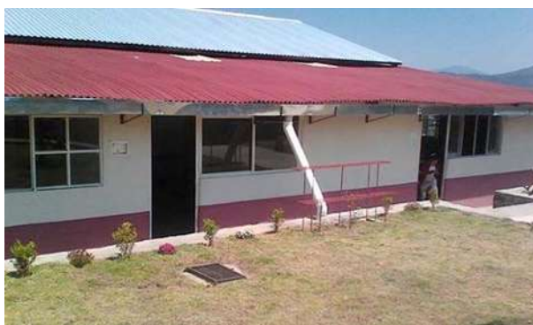
Figura 1.28. Sistemas de captación de agua de lluvia en el Colegio de Bachilleres plantel Paracho,
