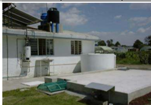
Figura 1.19 Sistema de Captación de Agua de Lluvia COLPOS 1, (en la figura izquierda se muestra el prototipo del diseño y en la derecha la implementación del SCALL), Fuente: CIDECALLI – CP 2008.
