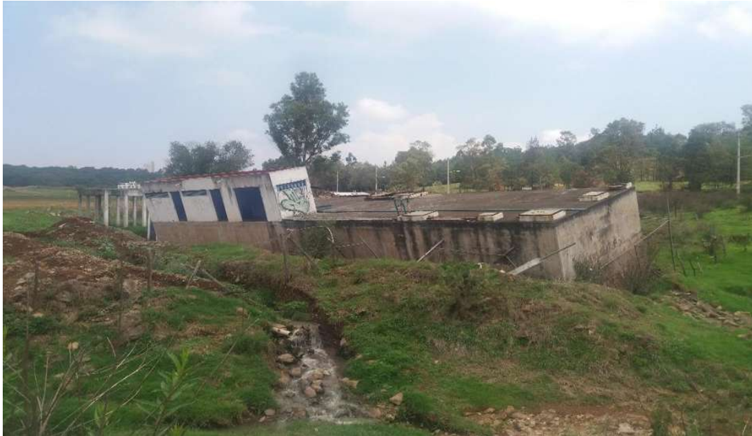
Imagen 14. Planta de tratamiento abandonada.
