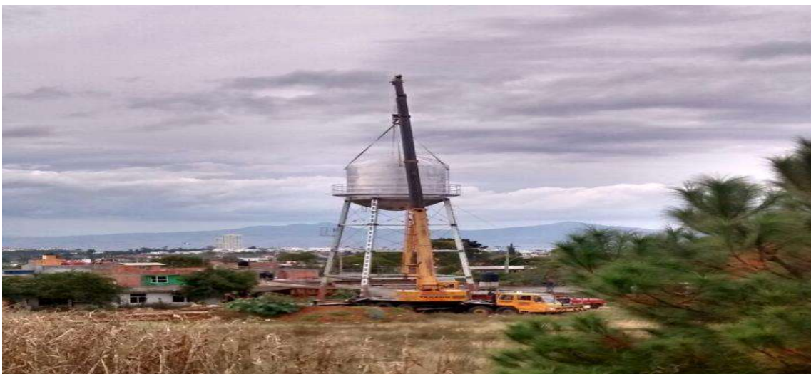
Imagen 16. Instalación de tanque elevado.
