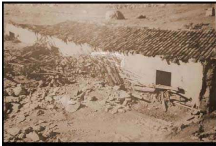
Figura 1.7.- Destrucción de las viviendas por el paso del flujo de detritos de 1959 (Arreygúe y Cortés, 2007).
