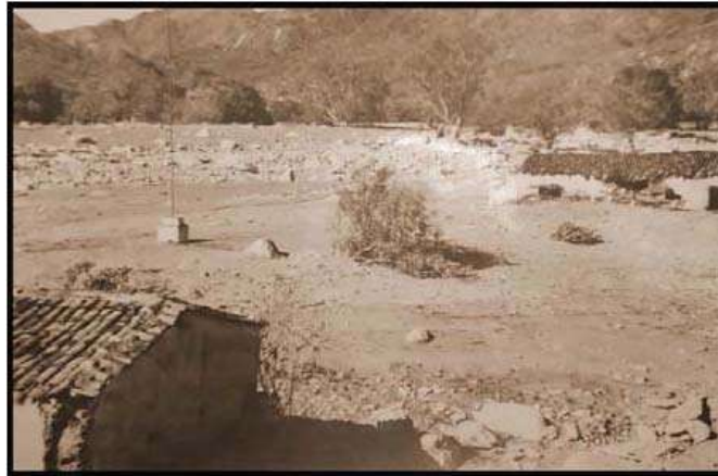
Figura A.- Destrucción de las viviendas por el paso del ciclón de 1959 (Padilla, 2006).
