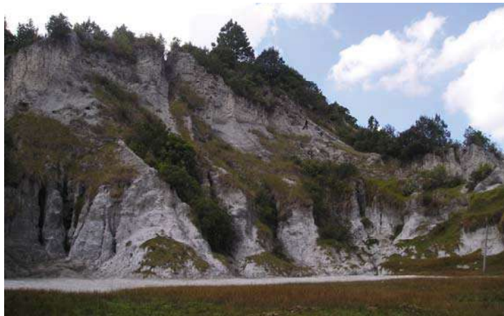
Figura 69. Erosión en los jales Tiro México
