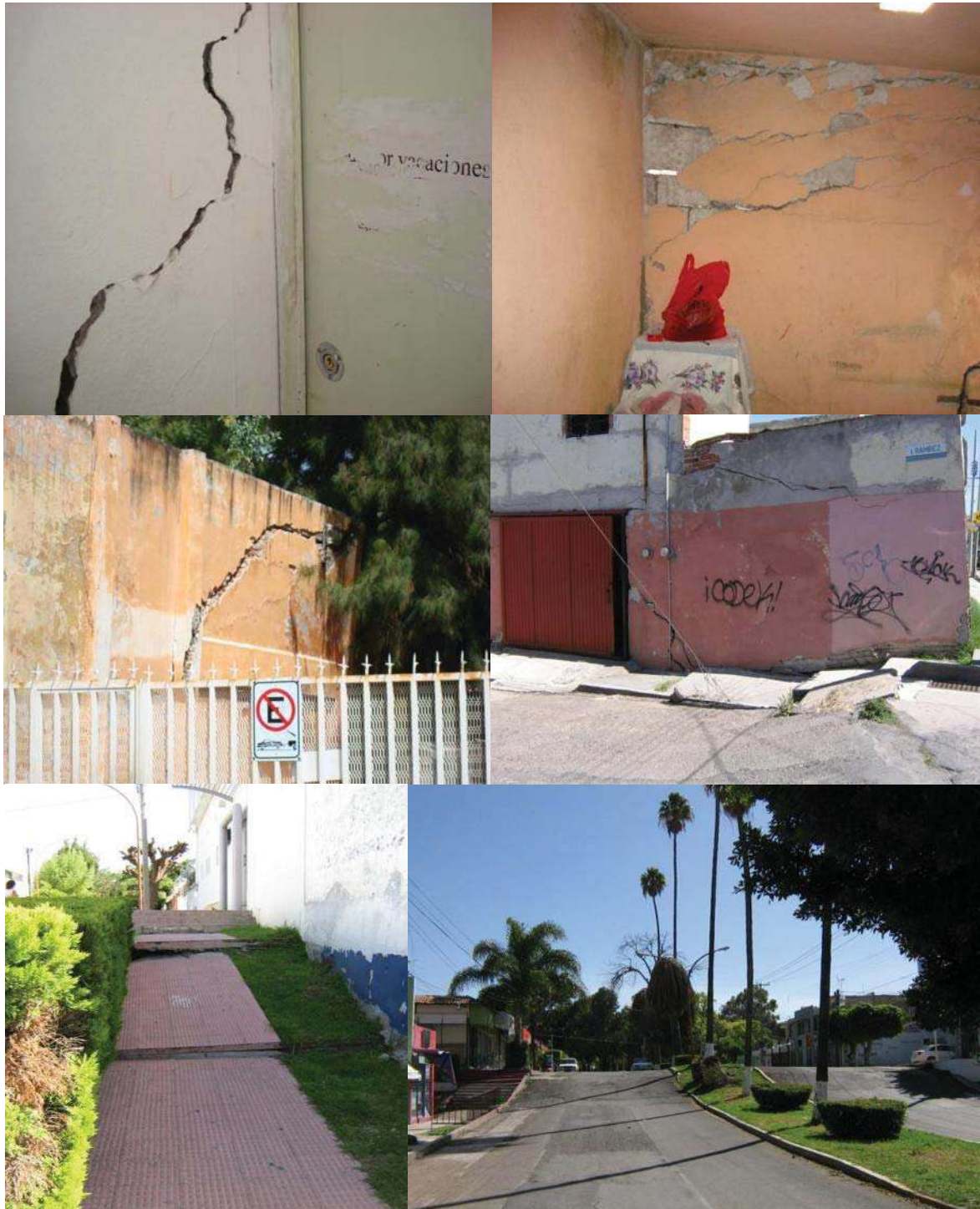
Fig. 28.- Falla Superficiales en Celaya, Gto. y sus Consecuencias Sup. Izq.- Falla Insurgentes, Sup. Der.- Falla Sta. Teresita, Centro.- Falla Poniente, Inferior.- Falla Oriente
