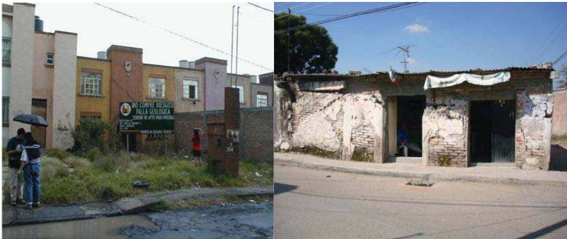
Fig. 1.- Obras civiles riesgosas debido a los PSCF en Morelia, Mich. y Celaya, Gto.
