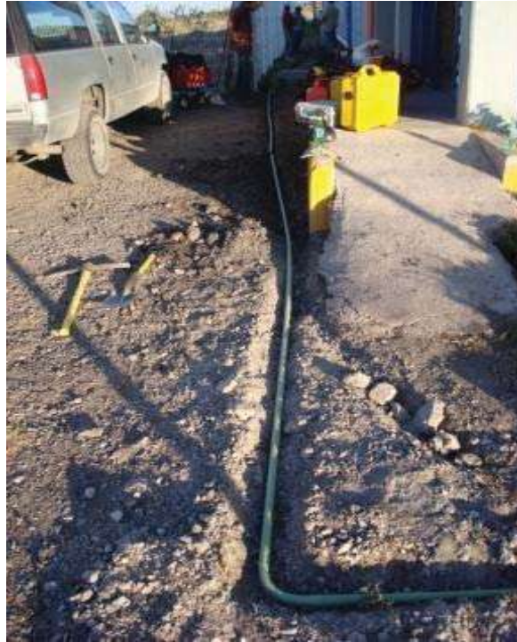
Fig. 33.- Trabajos de Excavación en la Base GPS Fija de “La Gavia”
