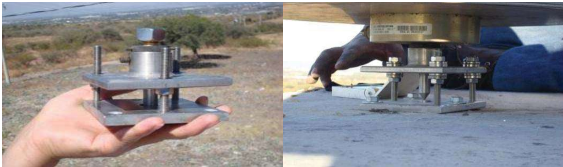
Fig. 34.- Trabajos de Montaje de la Base GPS Fija de “La Gavia”
